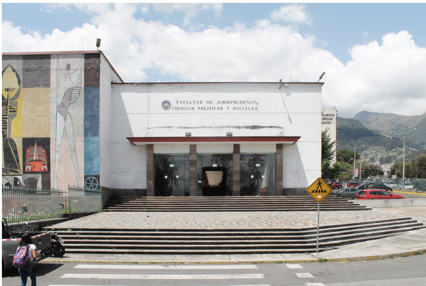
fig.350. vista del acceso principal a la Facultad de Jurisprudencia y Ciencias Sociales (estado actual). Una añadidura notoria, a más del mosaico, plaza frontal y espacio de parqueos antes mencionados, es la colocación de puertas de vidrio en el ingreso principal, vetando por completo la permeabilidad que se generaba a través de este espacio. Fuente: Autor.
