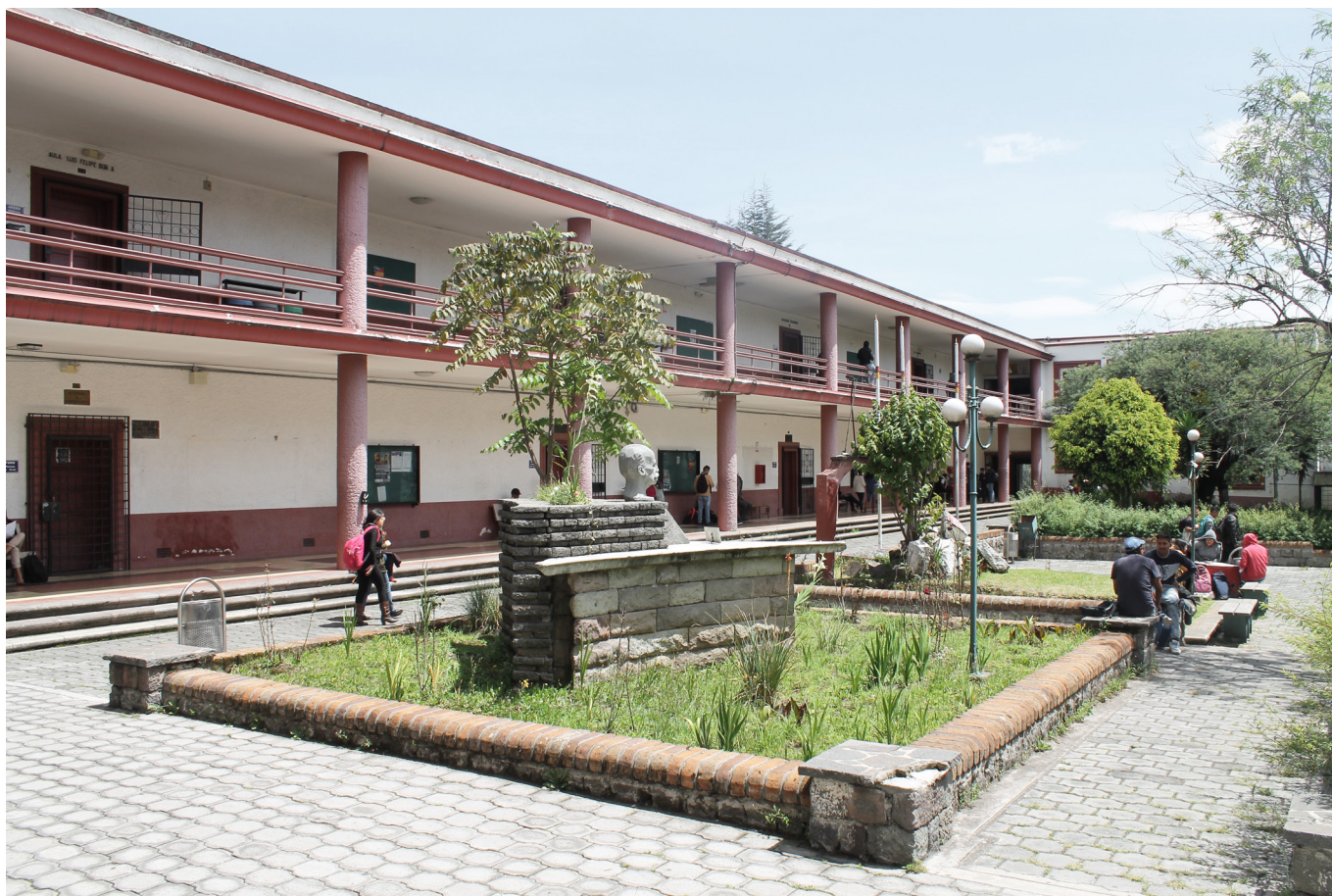
fig.342. vista desde el bloque administrativo de la facultad al bloque de aulas y patio central (estado actual). Se aprecia la conservación completa de los elementos arquitectónicos antes mencionados, por lo que no existen variaciones predominantes actuales. Nuevamente encontramos el cambio de color en la base de los muros y en las cornisas de los entrepisos en tonalidad roja. La generación de un nueva plaza en el espacio verde y la implantación de vegetación alta y baja en la patio central. Se aprecia un cerramiento metálico en el ingreso a las aulas de la facultad.
