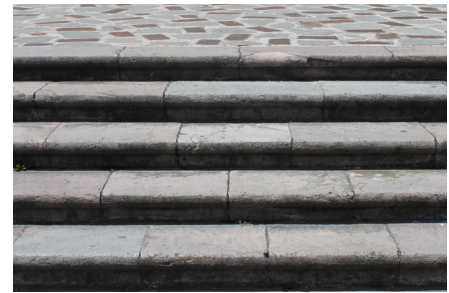
fig.410. Prefabricados de piedra en graderíos. Fuente: Autor.
