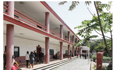
pórticos del bloque de aulas.
