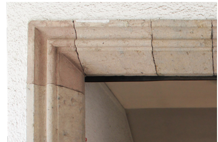
fig.409. Prefabricados de piedra en borde puertas y ventanas. Fuente: Autor.
