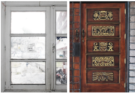
fig.405. Uso de madera labrada en puertas y ventanas. Fuente: Autor.
