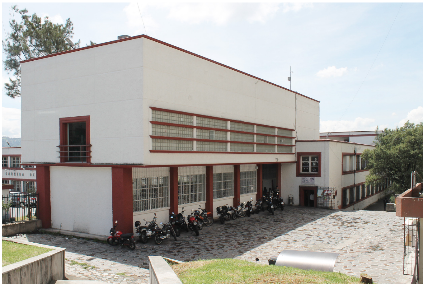
fig.349. vista posterior de la Facultad - Bloques biblioteca y administración-aulas (estado actual). La planta baja de la biblioteca es modificada, se cierra completamente en sus lados, inhibiendo el concepto de planta baja libre e ingreso principal, en este espacio funciona la zona de estudio de la biblioteca. Con respecto a los planos originales, la fuente de agua proyectada es retirada generando una amplia plaza frente a este bloque. Un ligera alteración pero a la vez notaria, es el retiro de la puerta de madera en la fachada lateral de la biblioteca, adjudicándole un vidrio claro para el paso de luz directa.
