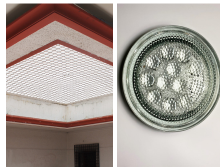
elemento circular de ladrillo translúcido sobre hall
