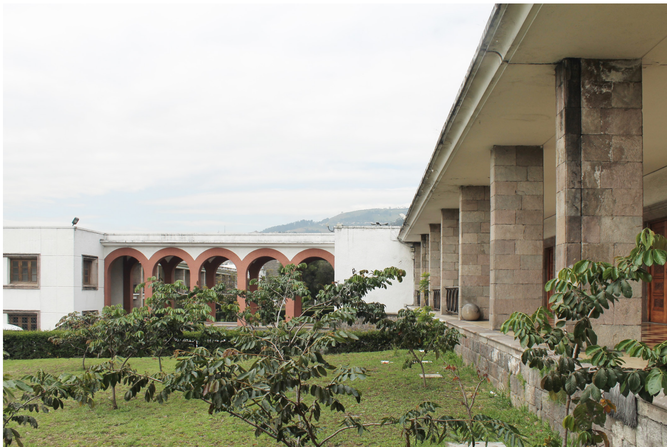
fig.256. Aquí se observa la zona del Editorial y el pasillo cubierto sin ninguna variación respecto a su construcción inicial; al igual que el anterior espacio, los bloques se conforman con el propósito de generar "patios", relacionándolos con el medio exterior. La zona de Editorial sufre una ampliación (año 1975) en la parte posterior, ante la necesidad de nuevos espacios y funciones para esta sección.
