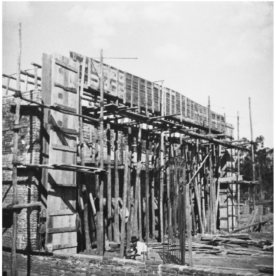
fig.249. Proceso de construcción del pórtico que conformaría la estructura del Auditorio Universitario. Fuente: Biblioteca UCE
