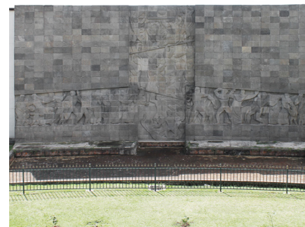
fig.332. Muro con bloques de piedra labrada. Fuente: Autor.
