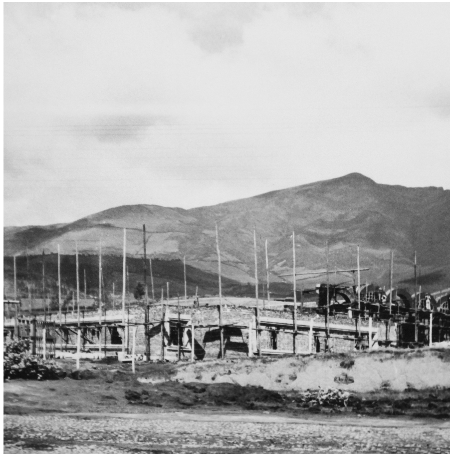
fig.239. Construcción de la planta baja del bloque administrativo / En el lado derecho se observa la construcción de los arcos que conforman el pasillo de conexión con la zona de Editorial.
