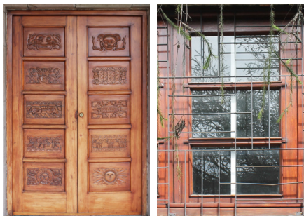
fig.322. Uso de madera en puertas y ventanas. Fuente: Autor.
