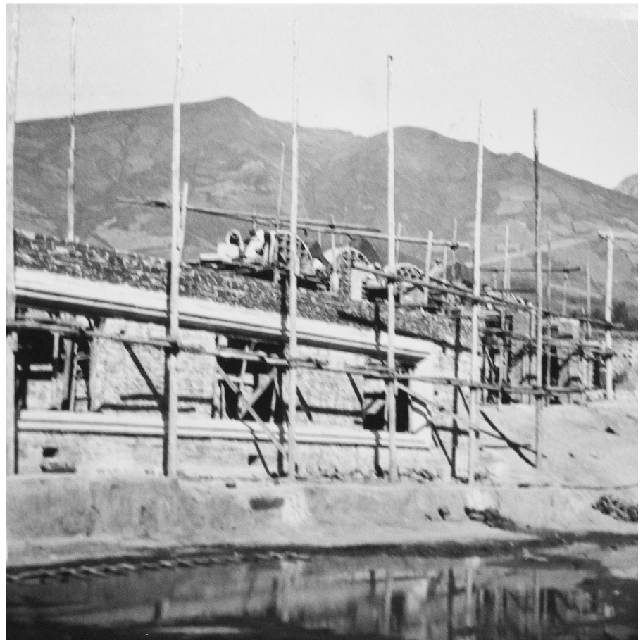
fig.241. Construcción de la planta baja del bloque administrativo, el espacio mostrado en la foto, corresponde a la vivienda del portero / En parte posterior se aprecia el encofrado para la construcción de los arcos que delimitan el pasillo de conexión con el otro bloque
