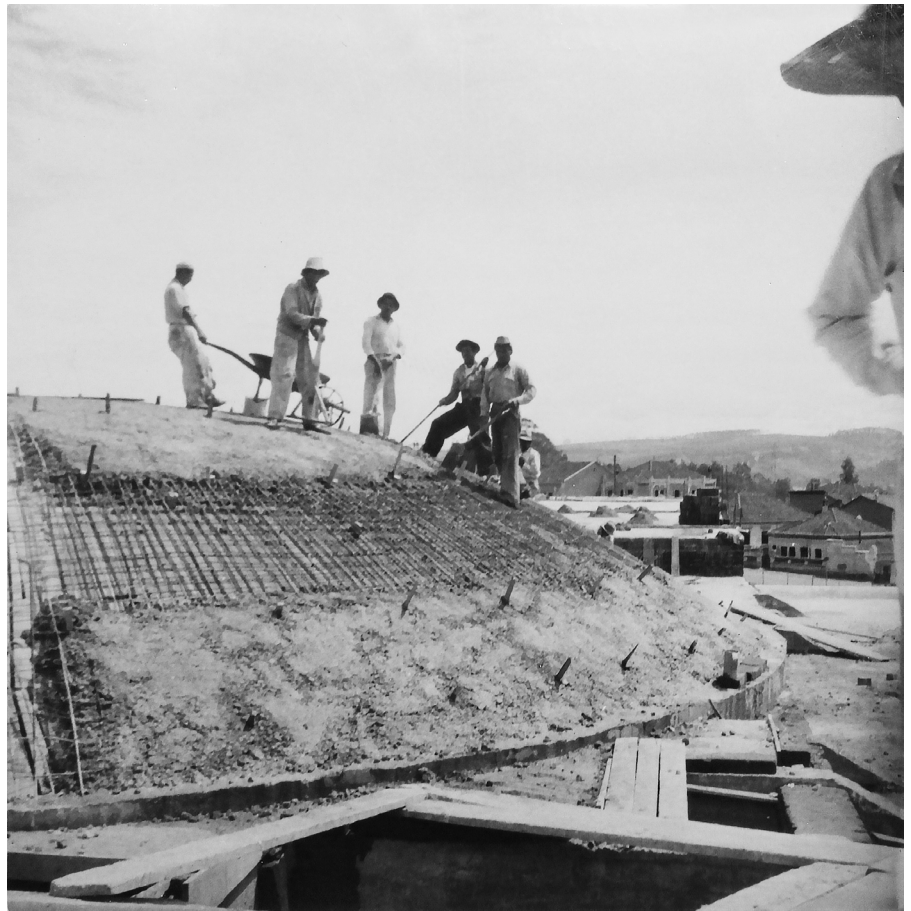
fig.245. Proceso de fundición de cúpula que corona el Hall principal
