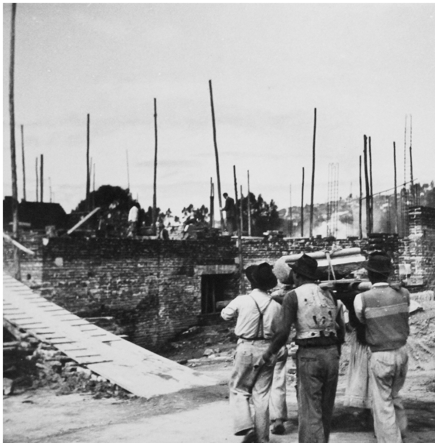
fig.240. Transporte de elemento prefabricado de piedra que será colocado en bordes de vanos de ventanas. Fuente: Biblioteca UCE
