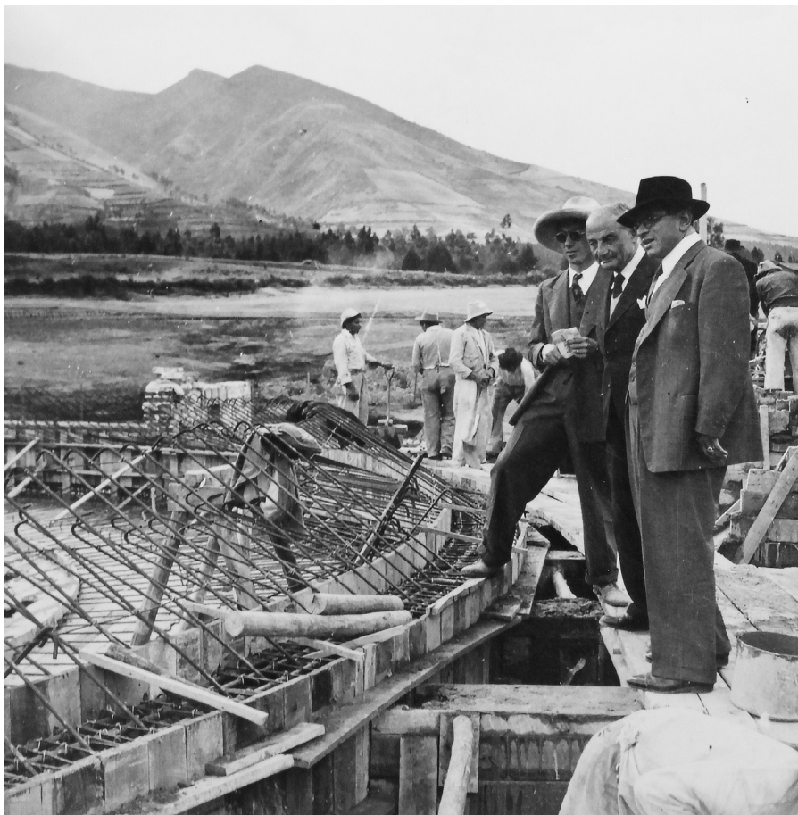
fig.243. Detalle constructivo de la cúpula que forma parte del Hall principal, se observa el proceso de armado de varillas; en este proceso se utilizaron varillas lisas / En la fotografía están representantes administrativos visitando la obra.
