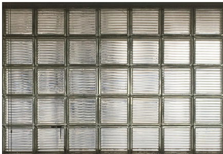
fig.321. Bloques de ladrillo traslúcido en fachada de biblioteca Fuente: Autor.
