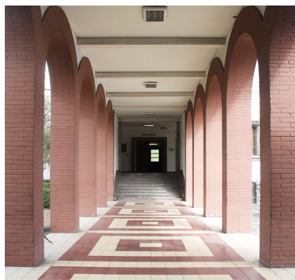
fig.331. Memorial de los pórticos de antigua universidad. Fuente: Autor.
