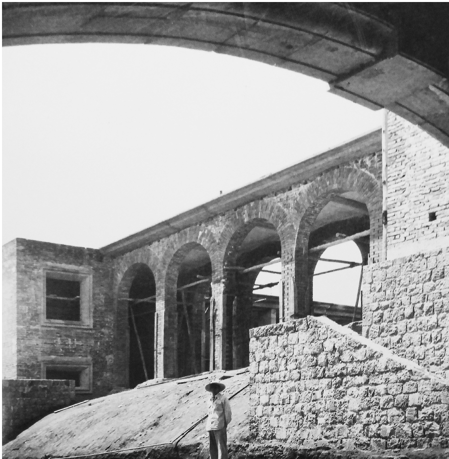
fig.246. Perspectiva capturada bajo el puente que permite el flujo vehicular, ubicada bajo el bloque de la Editorial Universitaria / Se observa la relación y conectividad de los diferentes bloques / El sistema constructivo realizado con un basamento de piedra propia de la zona, el sistema de muros y portantes de arcos, realizados con ladrillo artesanal macizo.
