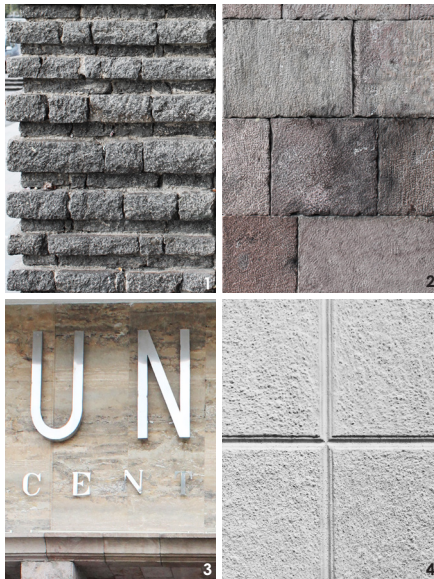
fig.320. Materiales de revestimiento. Fuente: Autor.
