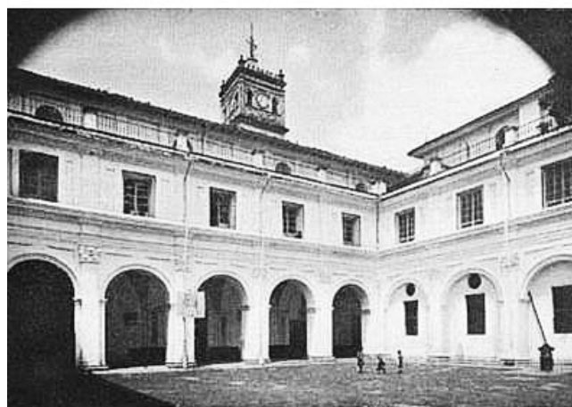
fig176. Claustro Sur (foto antes de 1900) Fuente: arquitecturatallerintegral.blogspot
