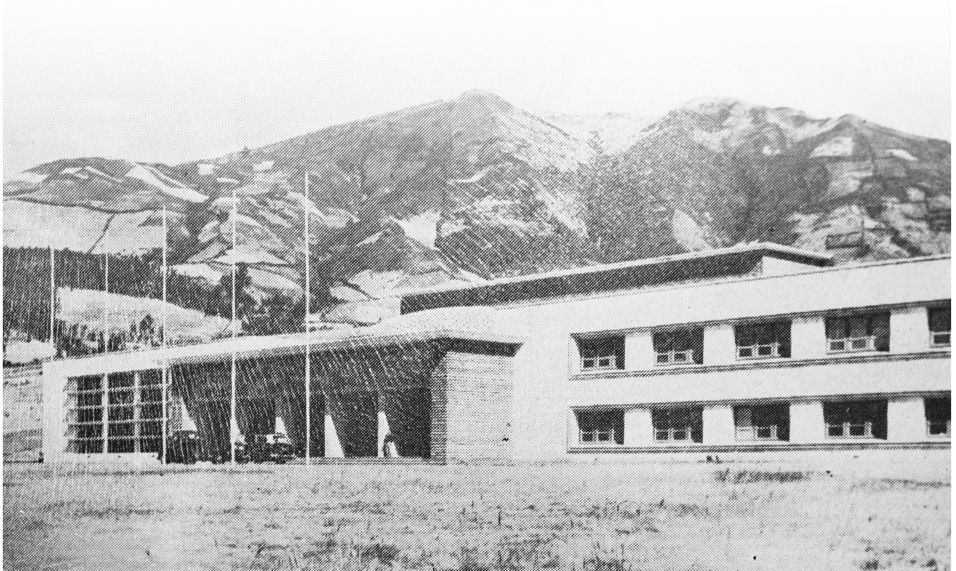
fig.185. Pabellón Administrativo - biblioteca, imprenta, rectorado y teatro (1949). La primera edificación construida en el nuevo lote de la Ciudad Universitaria y una de las primeras edificaciones vanguardistas en la arquitectura moderna en el Ecuador; se evidencia la horizontalidad de la edificación y una completa relación con el paisaje circundante (emplazado en las faldas del Pichincha)
