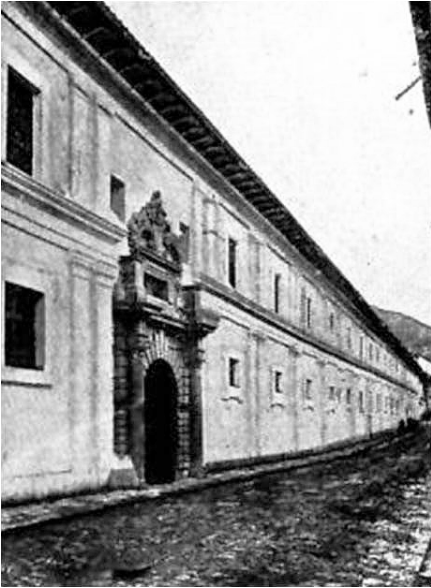
fig.177. Fachada principal antes del flagelo y derrocamiento
