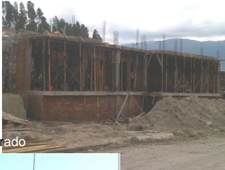
Imagen 22: Encofrado
