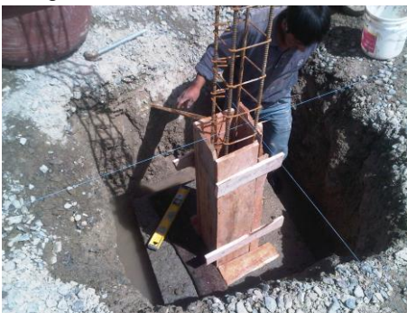
Imagen 21: Encofrado
