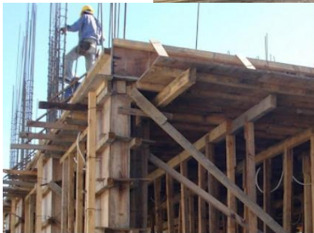
Imagen 23: Encofrado
