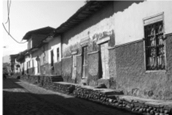
Ilustración 9: Fotografía antes de la intervención en la calle Rafael María Arízaga
