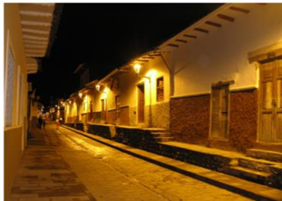
Ilustración 10: Fotografías después de la intervención en la calle Rafael María Arízaga
