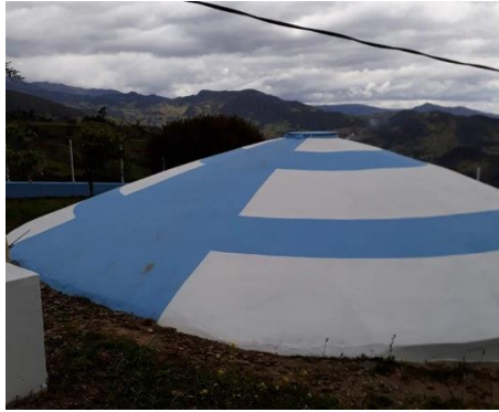
Fotografía 4. Tanque de almacenamiento de planta de tratamiento.
