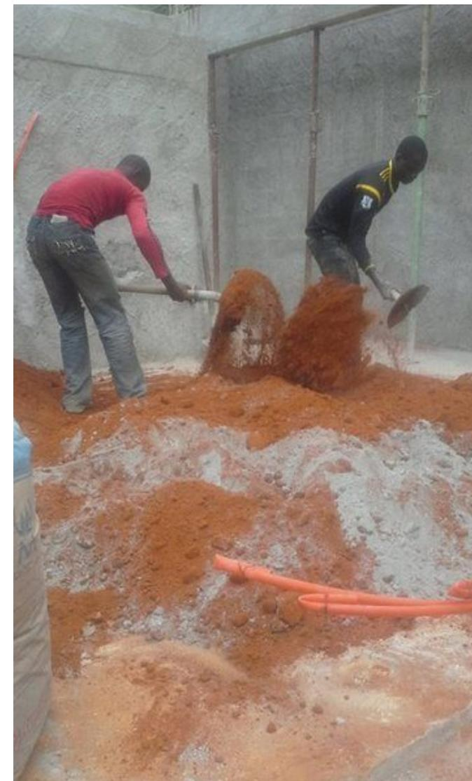
Imagen 2.9 Mezclado proyecto de recuperación / ampliación de edificio en tapial
