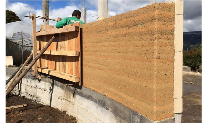
Imagen 2.1 Encofrado de tapial
