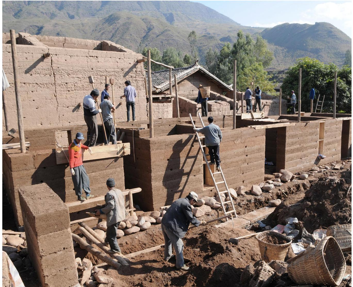
Imagen 2.17 Levantamiento y secado de muros tapial
