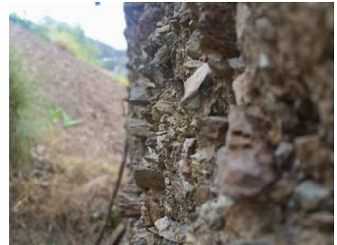
Imagen 1.4 Deterioro muro de tapial
