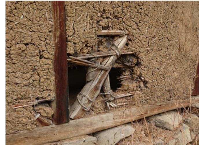
Imagen 1.3 Deterioro muro de bahareque
