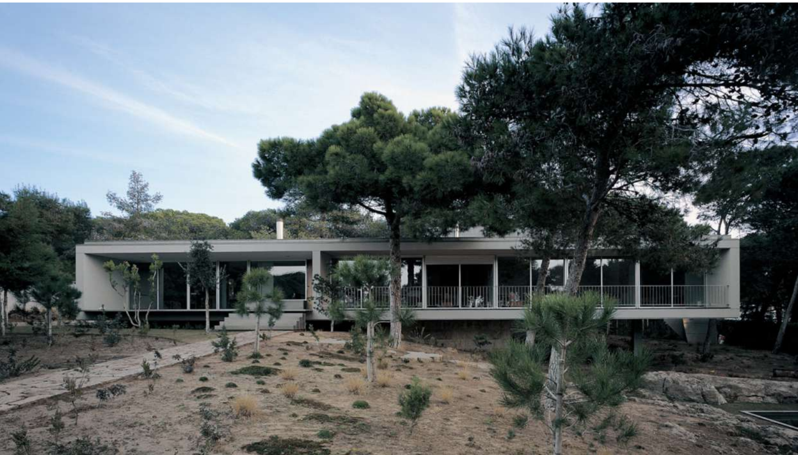
09. vista panoramica alzado sur.
