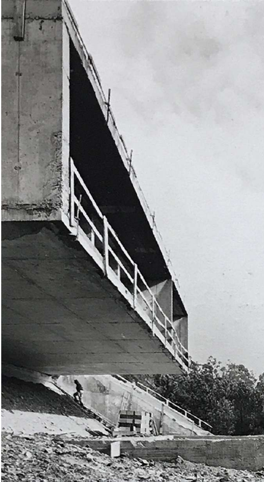
22. vista en obra desde la casa I hacia la casa II.
