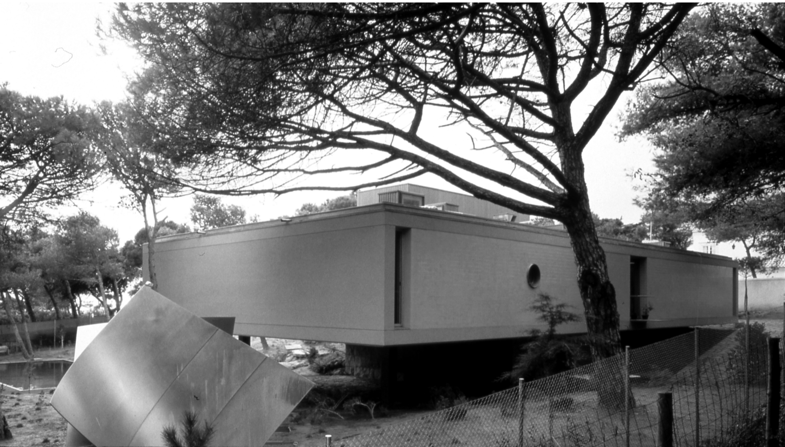
26. perspectiva posterior, obra finalizada.
