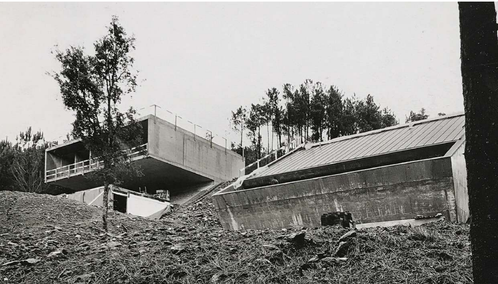
11. Ponte de Lima, vista general en obra.
