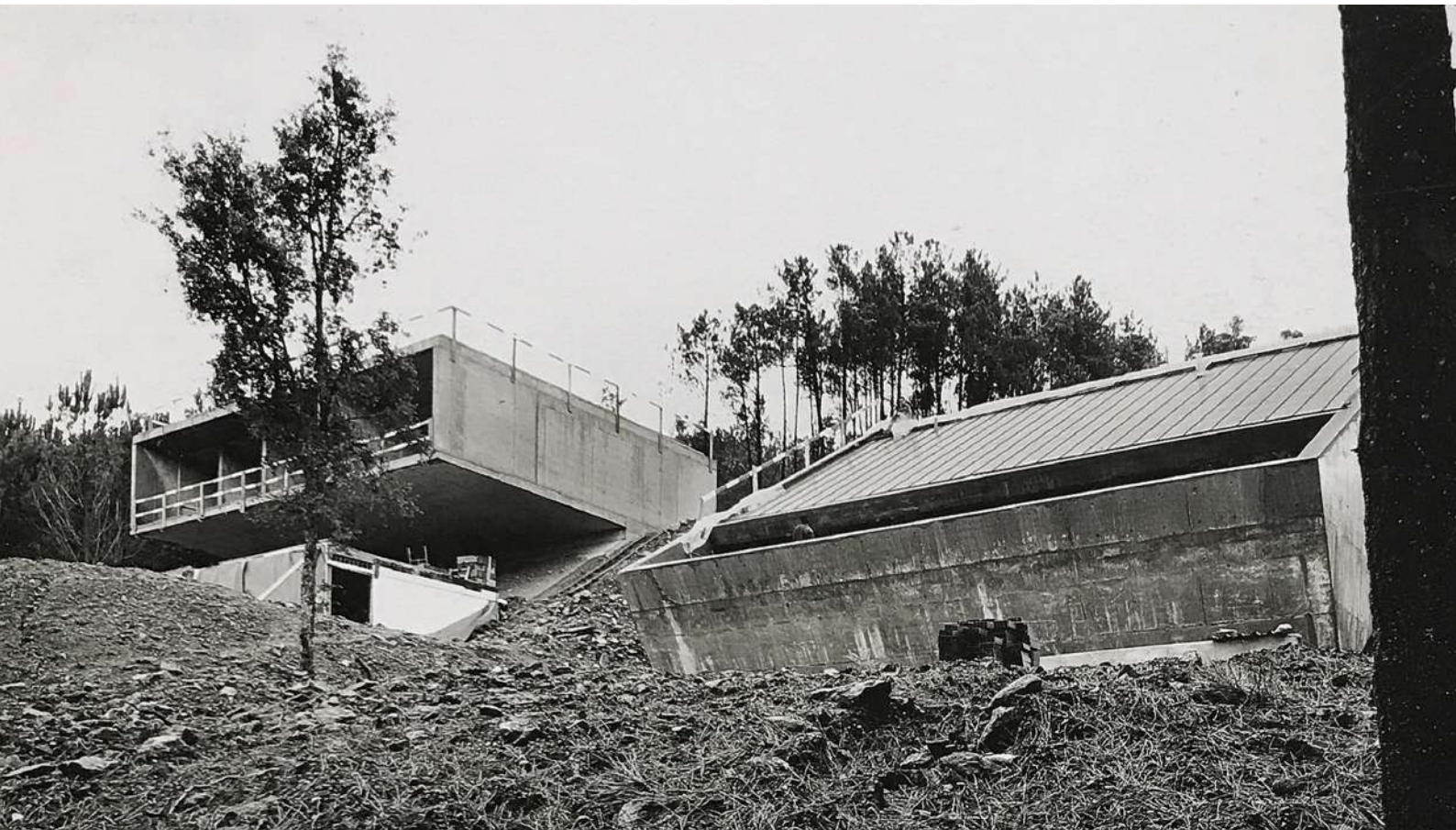
19. vista general en obra.
