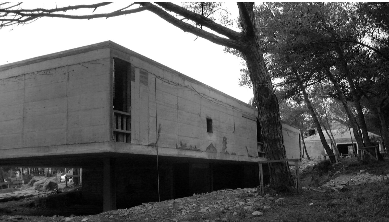
25. perspectiva posterior en obra.
