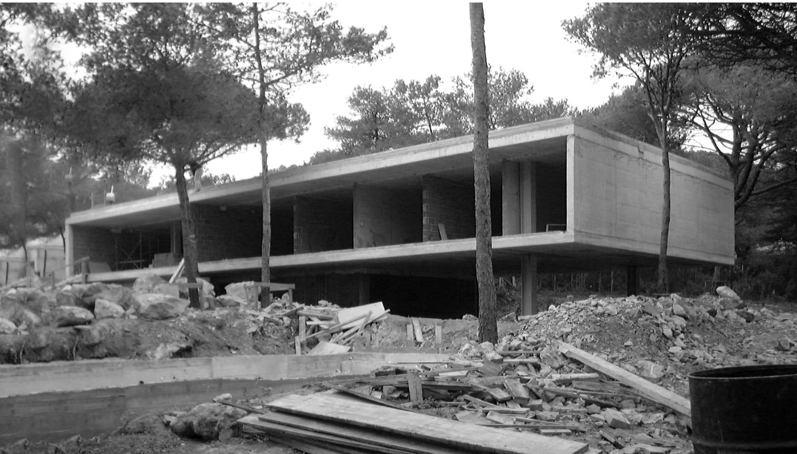
21. vista general en obra, fachada principal.
