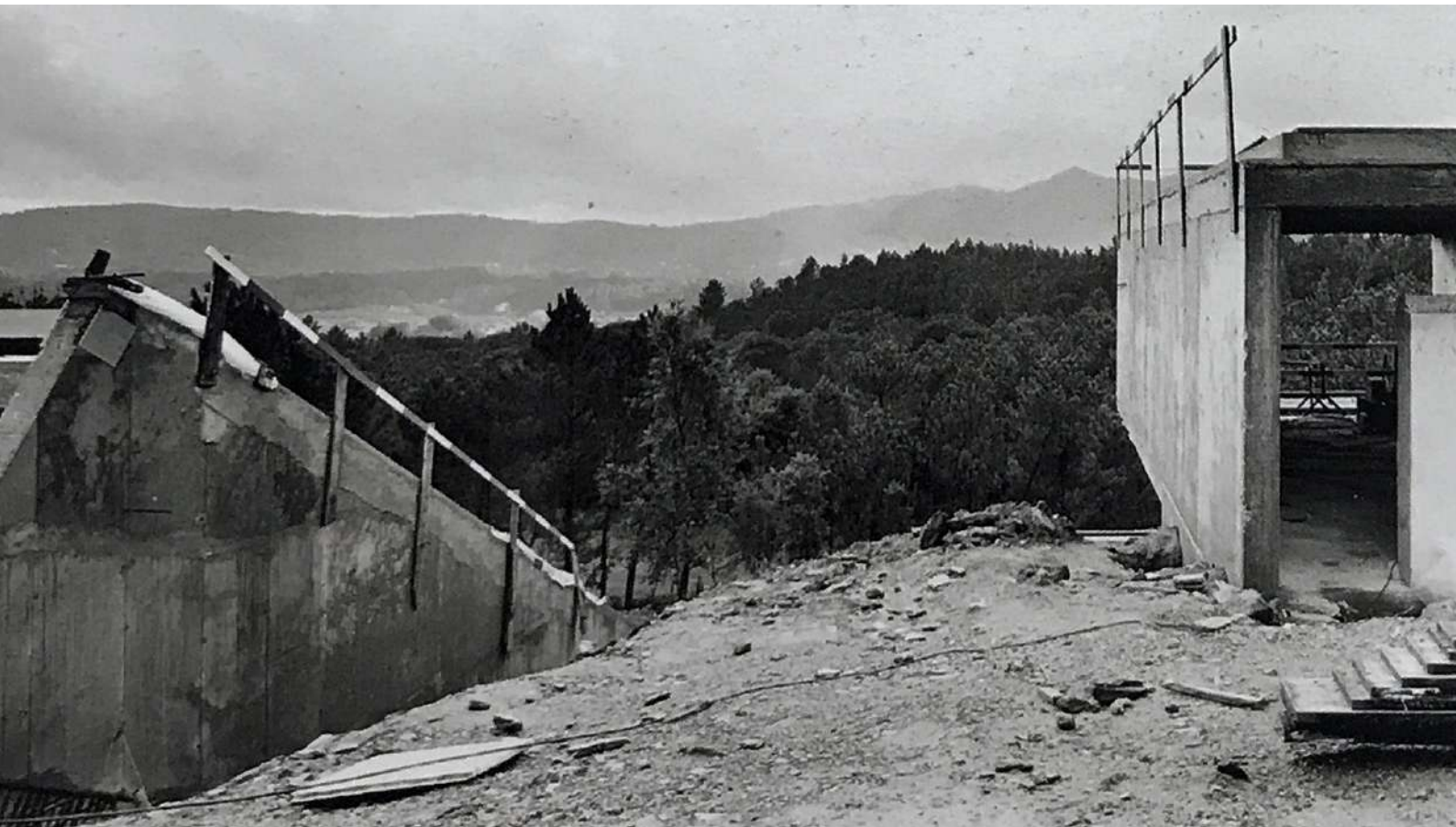
23. vista general en obra hacia el paisaje.
