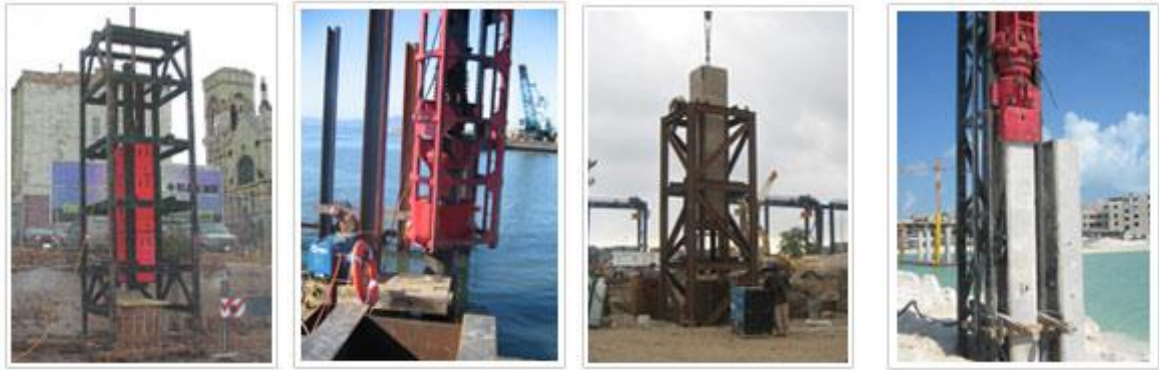
Figura 1.29 Ensayos dinámicos en pilotes
