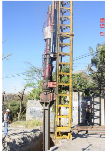
Figura 1.1 Martillo para hincado de pilotes
