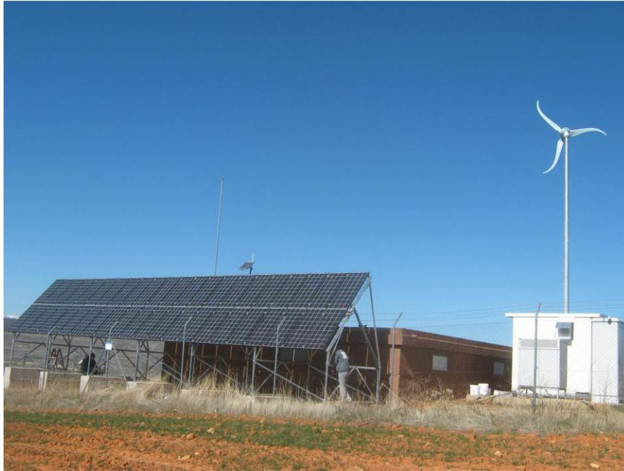
*Figura 4. Generación distribuida de un sistema fotovoltaico y un generador eólico
