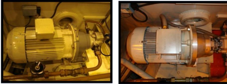
**Figura D.7** Alta Presión Bomba AC.
