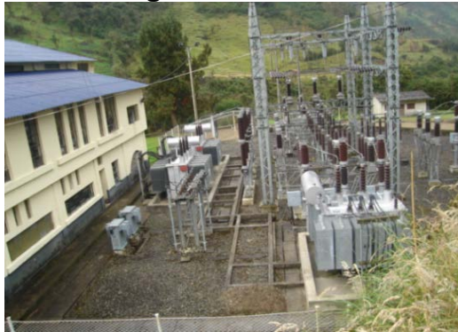
Figura 3 Central Hidroeléctrica Fernando Malo (Saucay)
