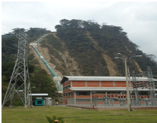
Figura 5 Central Hidroeléctrica Ocaña
