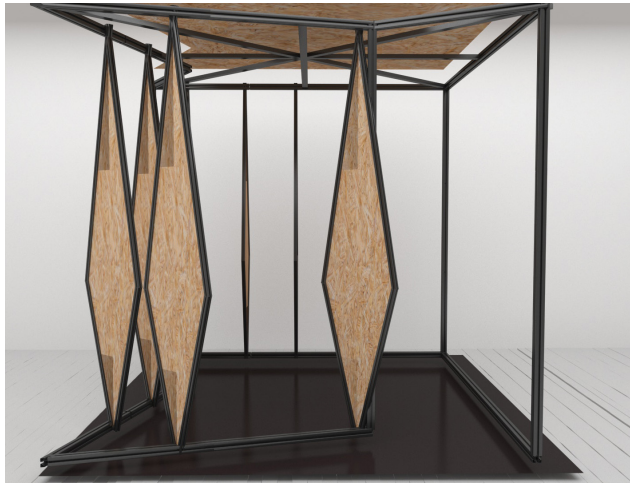
Paso 7: Posteriormente en el cielo raso se coloca un tablero de OSB de 15mm que sirve como cubierta del stand.
