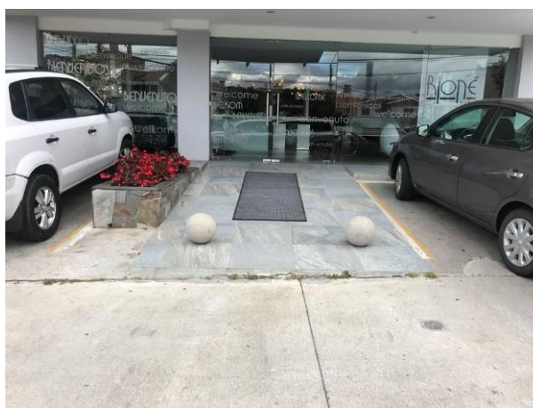
Fotografía 1: Rampa de Acceso
