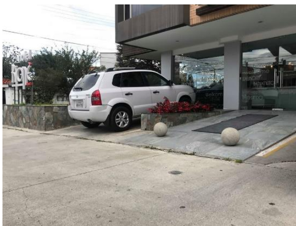
Fotografía 3: Rampa de acceso Autor: Guido Flores – Johanna Ángel Fuente: Propia.
