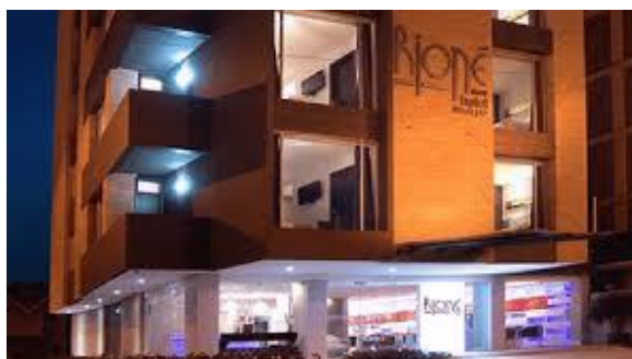
Fotografía 4: Marquesina de Protección para el Ingreso al Hotel
