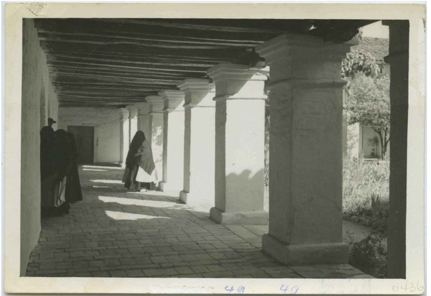
Corredor del patio principal del Monasterio del Carmen Foto: NN, 1950-1960, Fondo Nacional de Fotografía, Museo Pumapungo.
