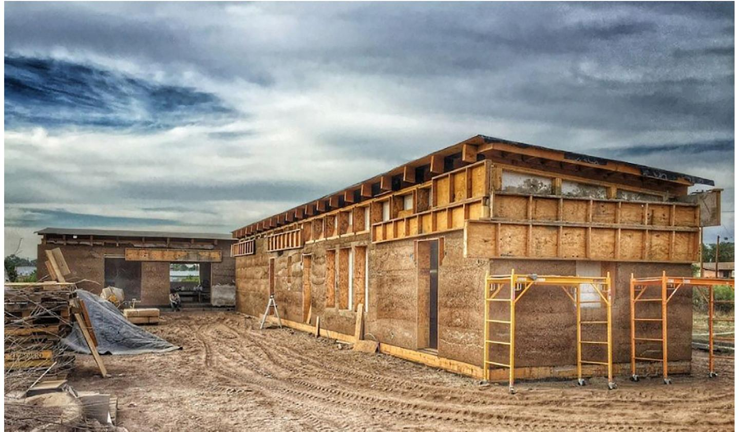
Fotografía 11. Vivienda con mampostería de cáñamo y estructura de madera. Vivienda con cáñamo.
