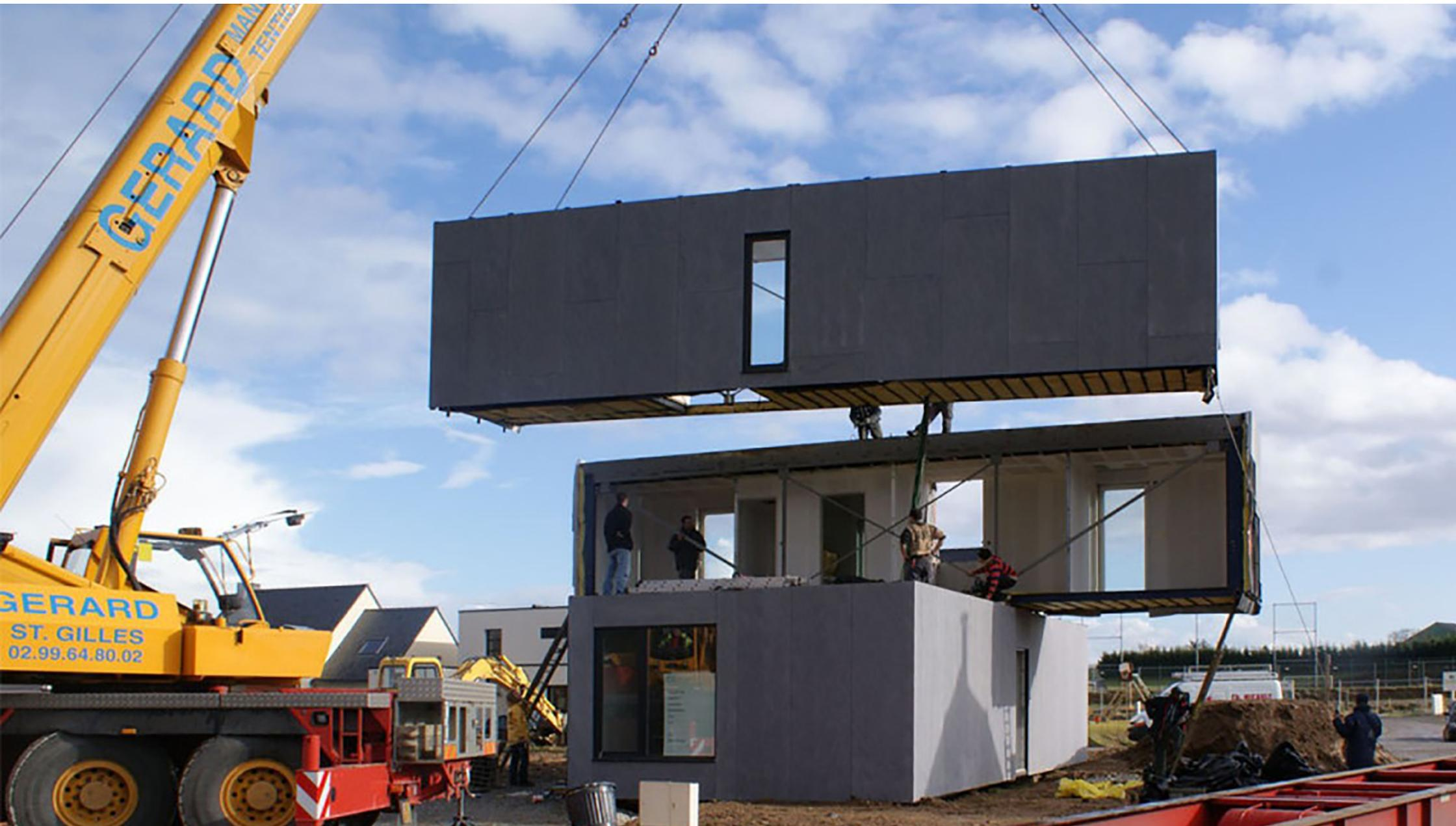
*Fotografía 31. A Cantilevered modular house, CG ARCHITECTES.*
