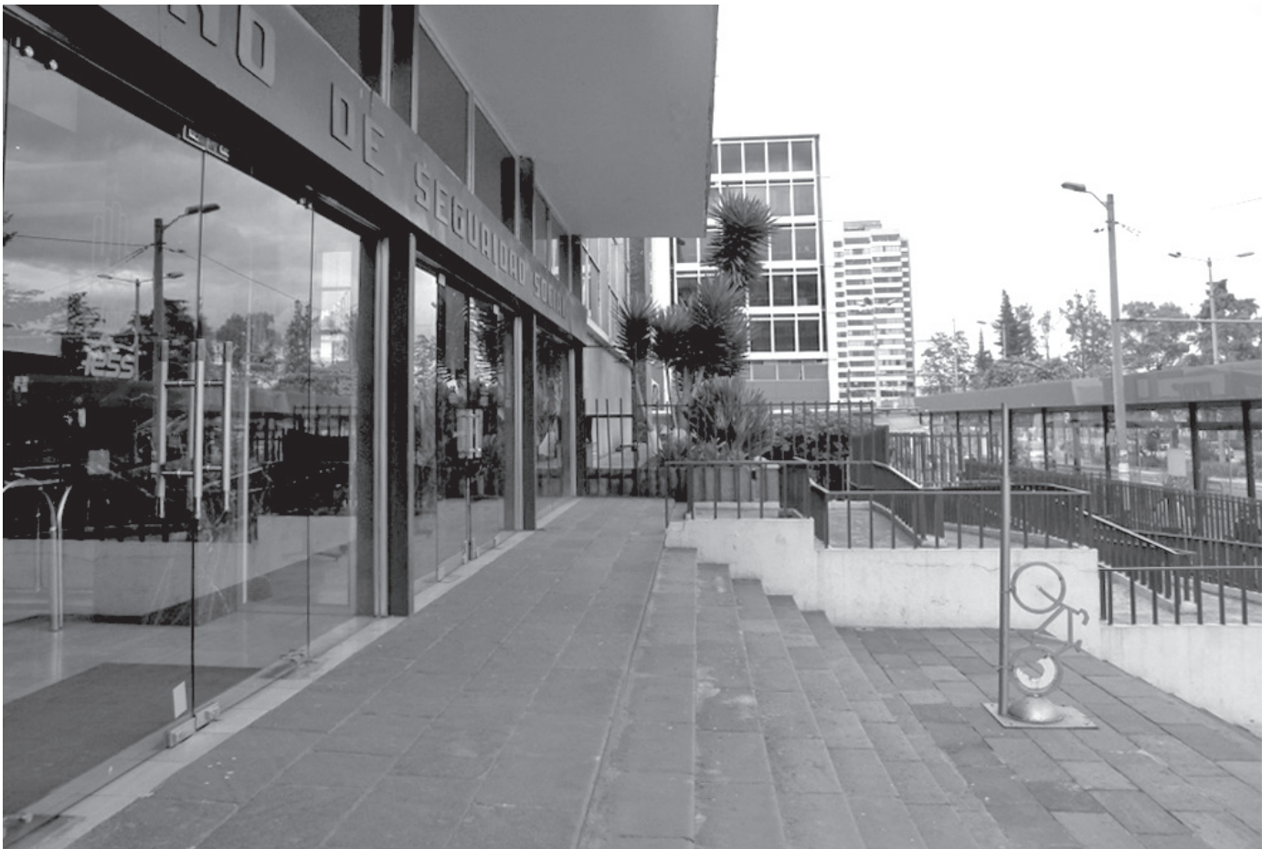
184. Edificio IESS - Acceso
