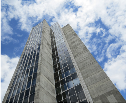
134. Edificio Cofec - Cerramiento
