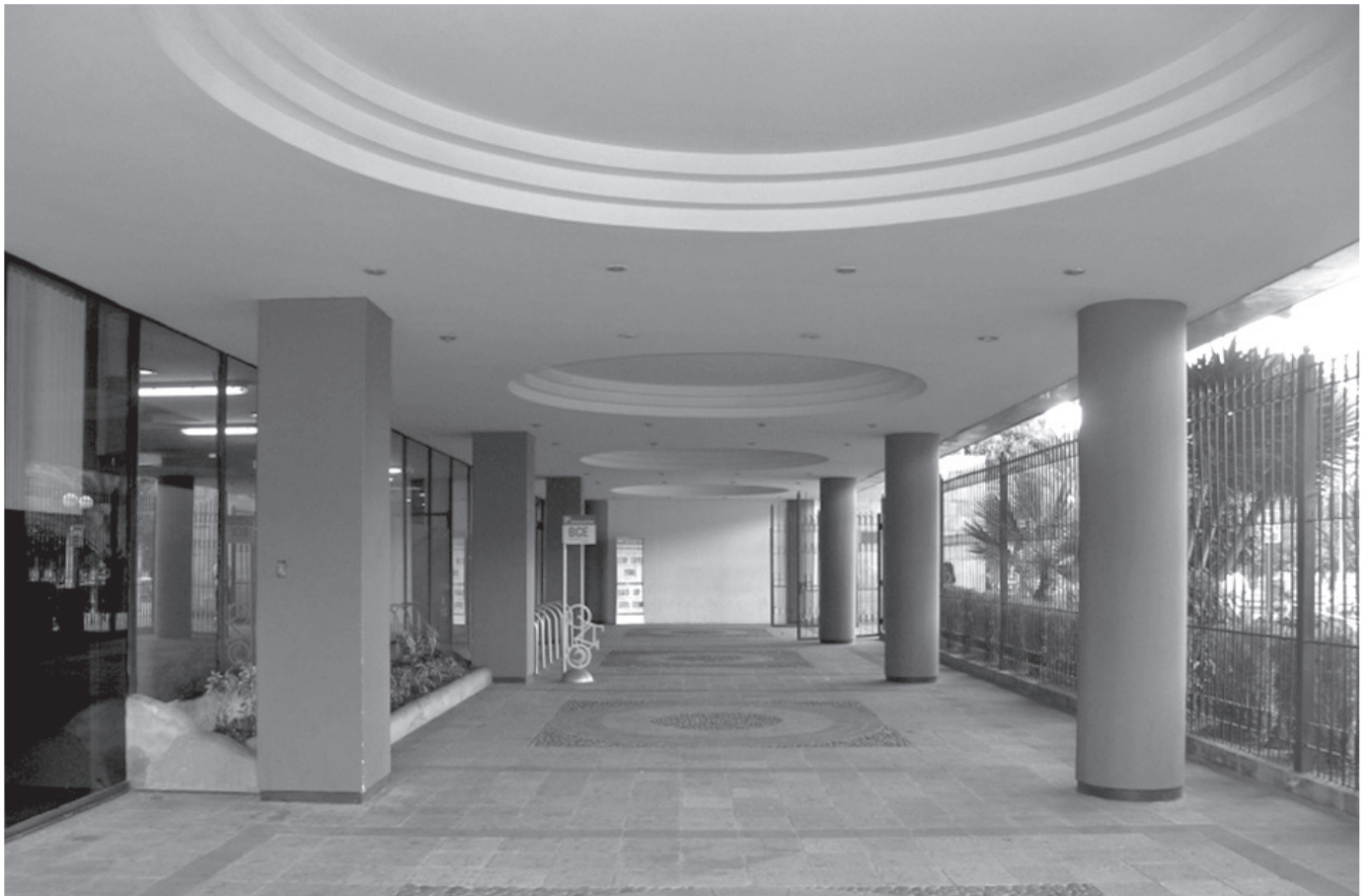
232. Edificio Banco Central - Elementos estructurales, 2017
