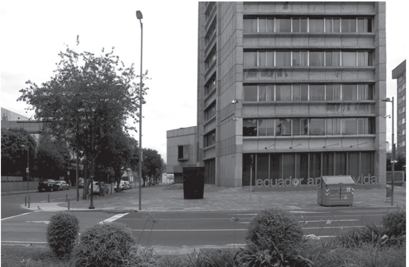
159. Edificio CFN - Exterior desde avenida Patria
