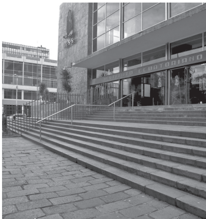
183. Edificio IESS - Acceso
