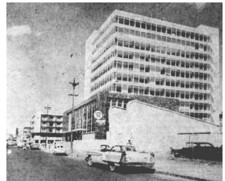
188. Edificio IESS - (fotografía de época)
