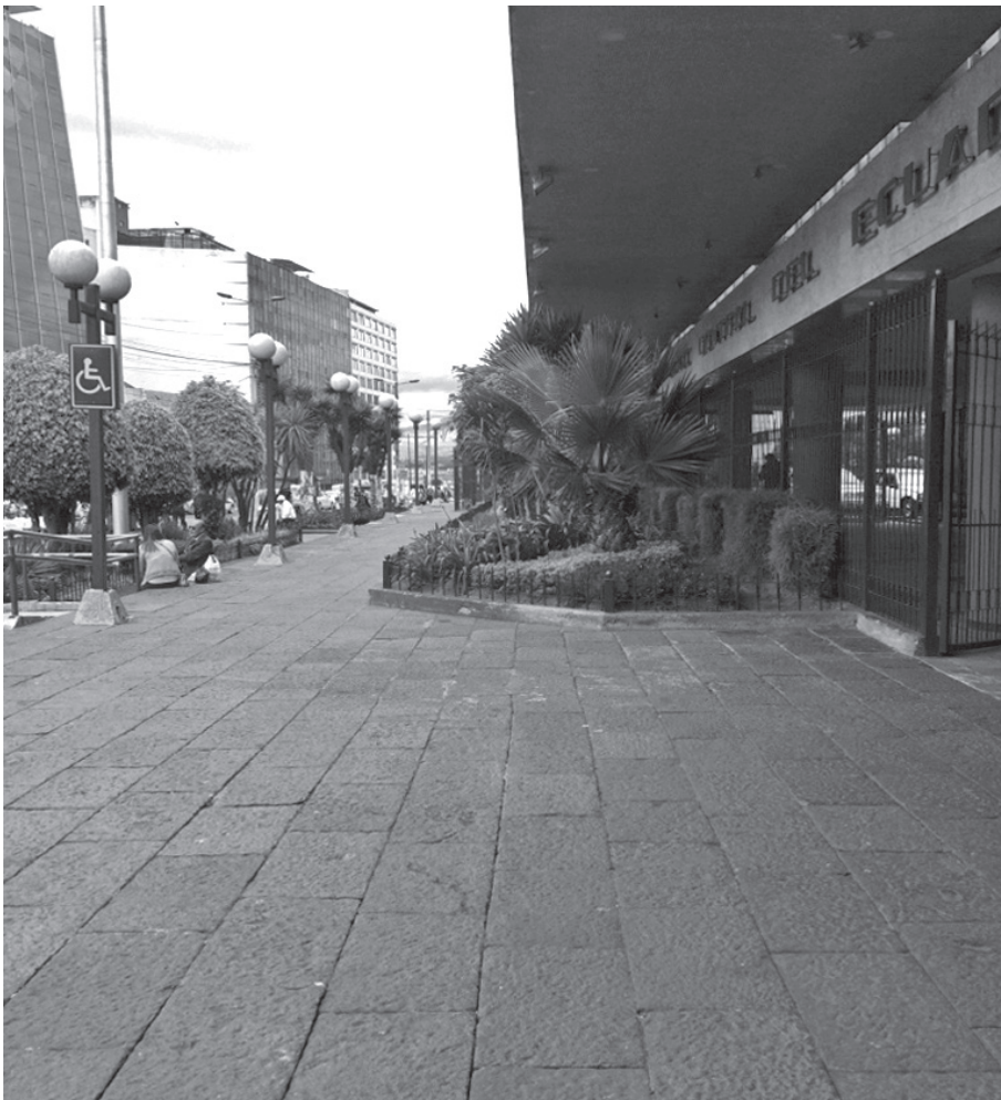
225. Edificio Banco Central - Atrio frontal, 2016
