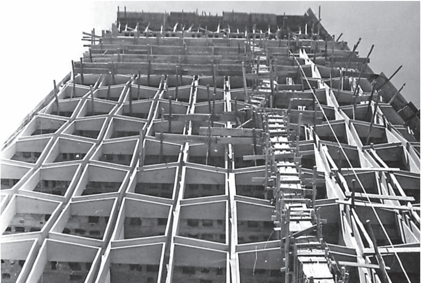
262. Benalcázar Mil - Piezas prefabricadas cerramiento (fotografía de época)
