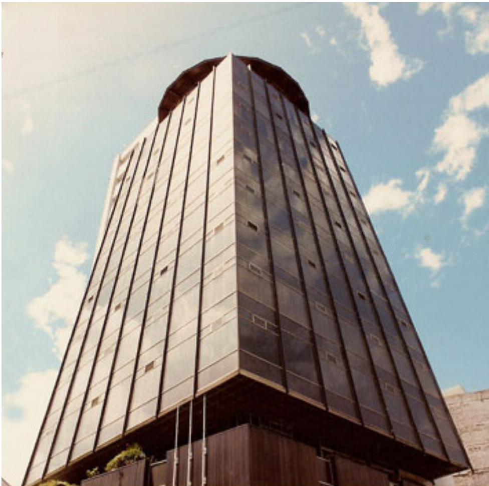
300. Edificio Filantrópica - Cerramientos
