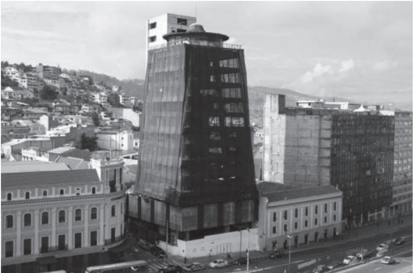
292. Edificio Filantrópica - En restauración, 2014
