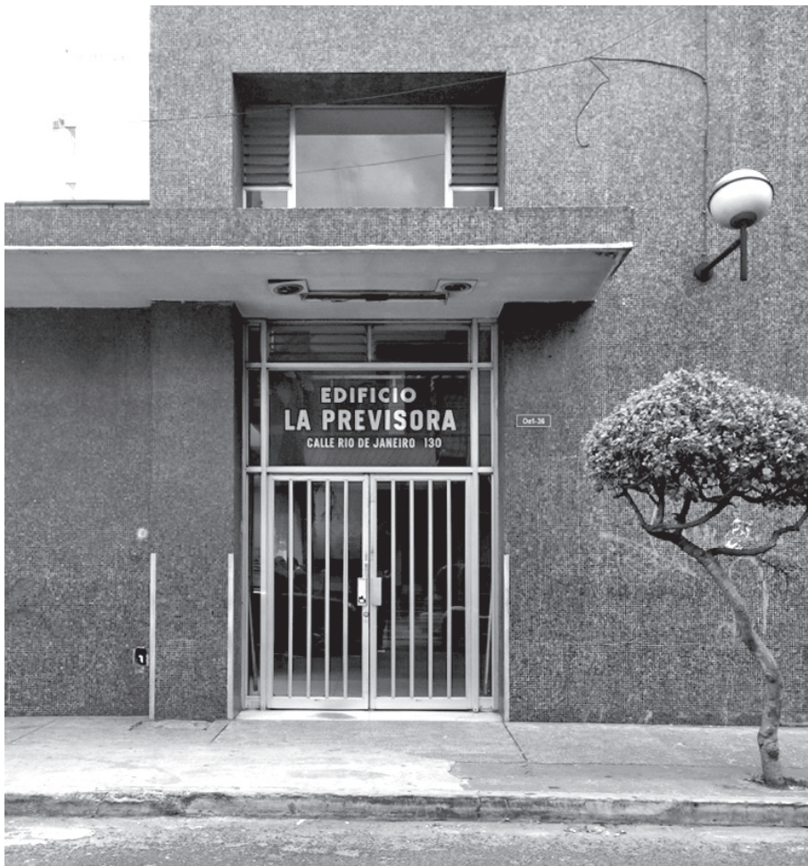
205. Edificio Previsora Norte - Acceso secundario
