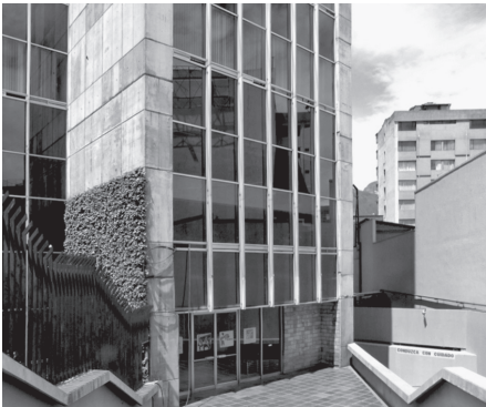
129. Edificio Coftec - Acceso secundario
