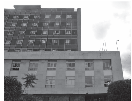
235. Edificio Banco Central - Cerramientos
