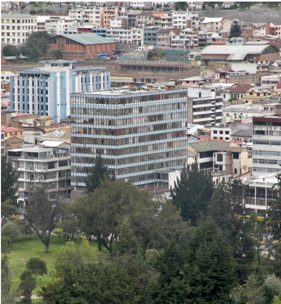
195. Edificio Previsora Norte - Vista aérea
