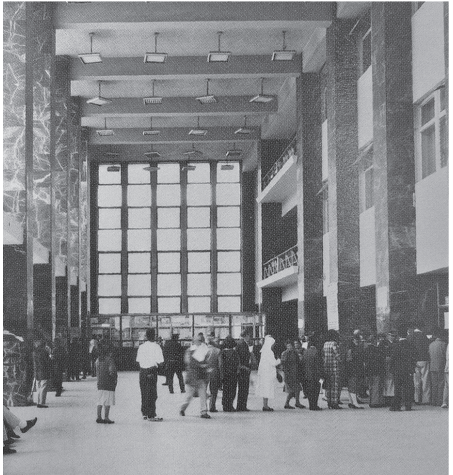
189. Edificio IESS - (fotografía de época)
