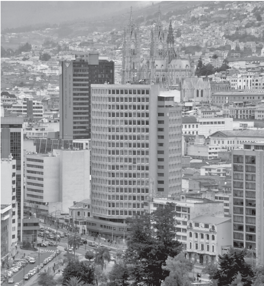
248. Edificio Benalcázar Mil - Vista aérea
