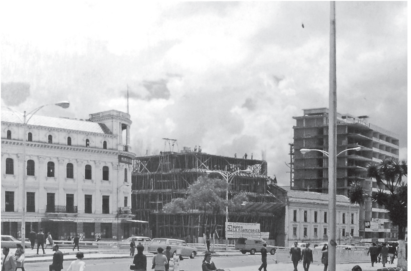
54. Edificio Filantrópica - construcción (fotografía de época)
