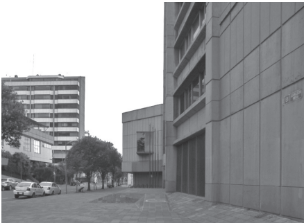
162. Edificio CFN - Circulaciones
