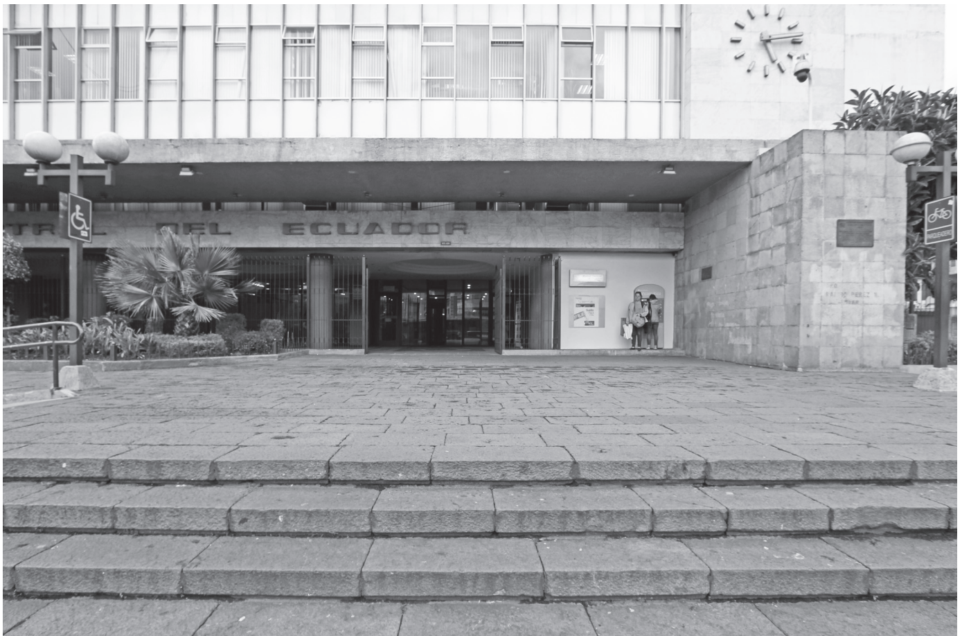
230. Edificio Banco Central - Acceso principal
