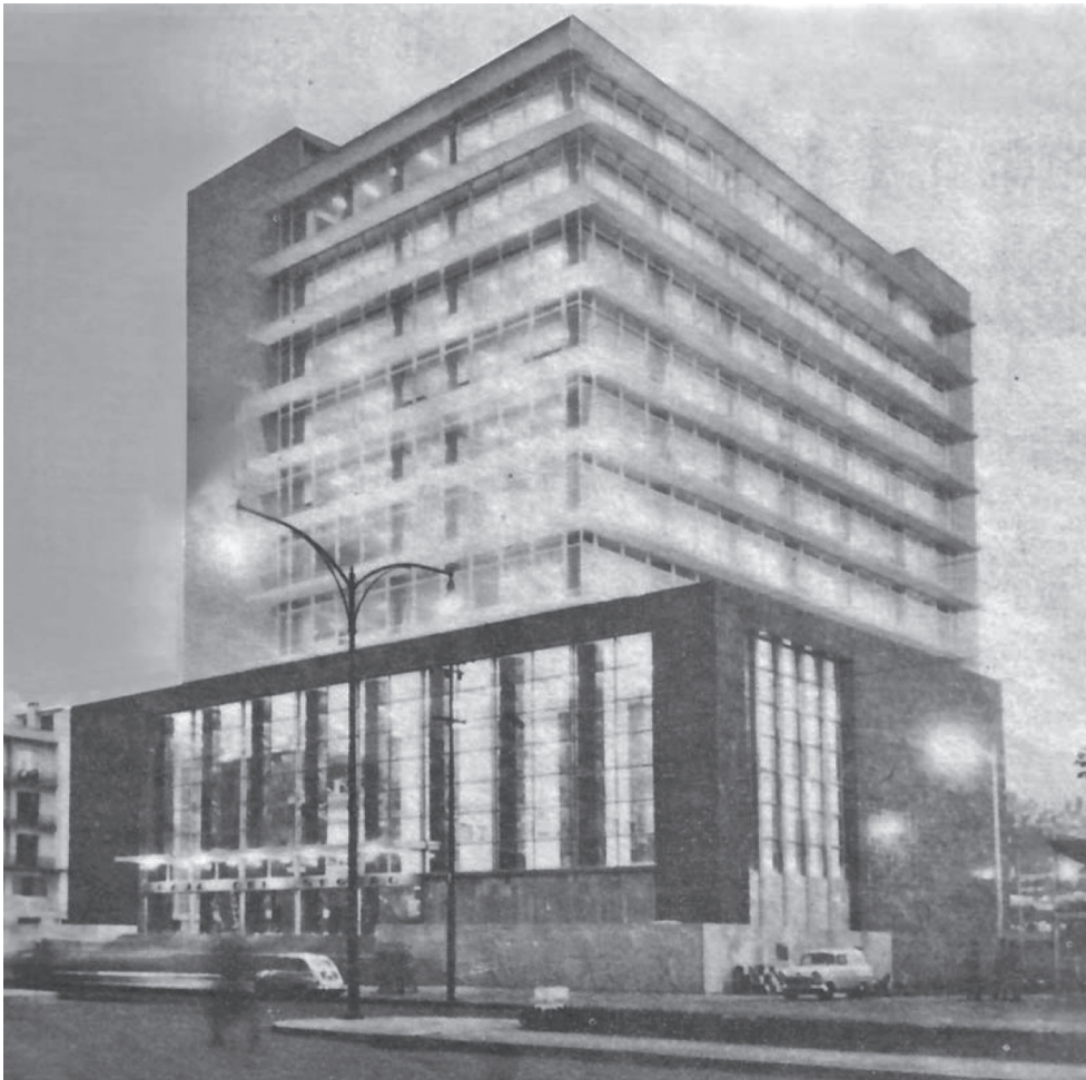
179. Edificio IESS - (fotografía de época)
