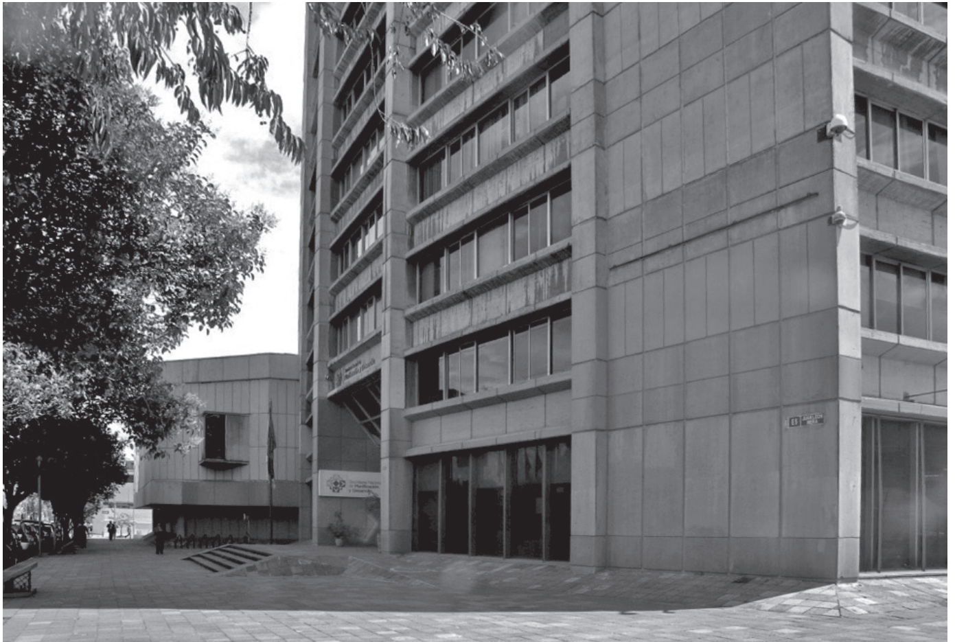
149. Edificio CFN - Plaza exterior y atrio
