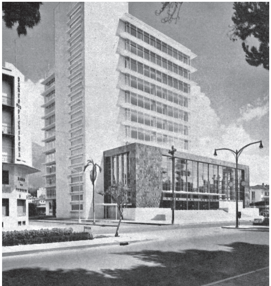
169. Edificio IESS - (fotografía de época)
