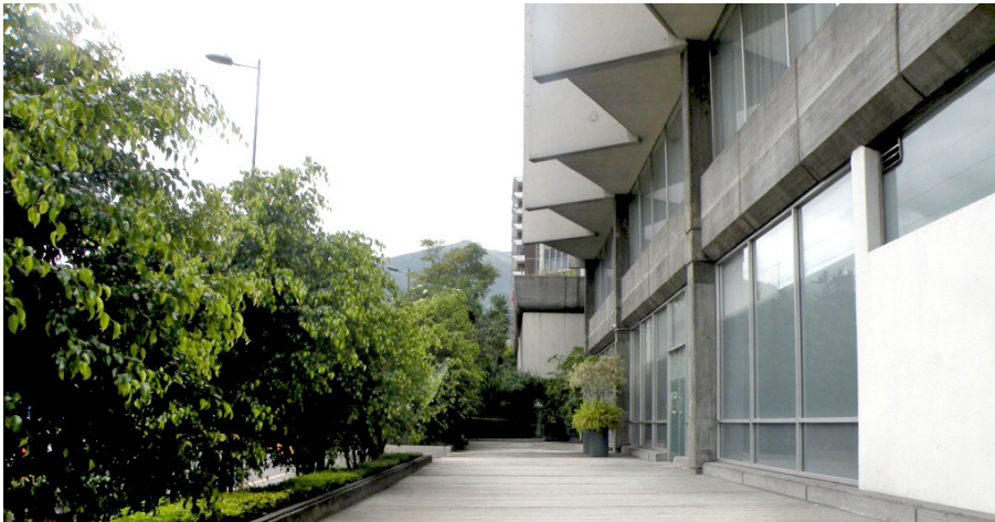
101. Hotel Colón - Estructura expuesta en nivel inferior de torre Sur.
