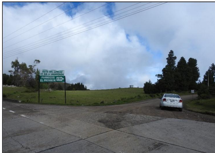
Figura 6. Vía de acceso a la Parroquia El Progreso. Investigación Pachar, 2018.
