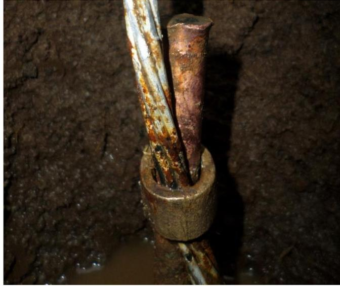
**Figura 4.8.** Oxidación entre el conductor y la varilla copperweld. (fuente autores)
