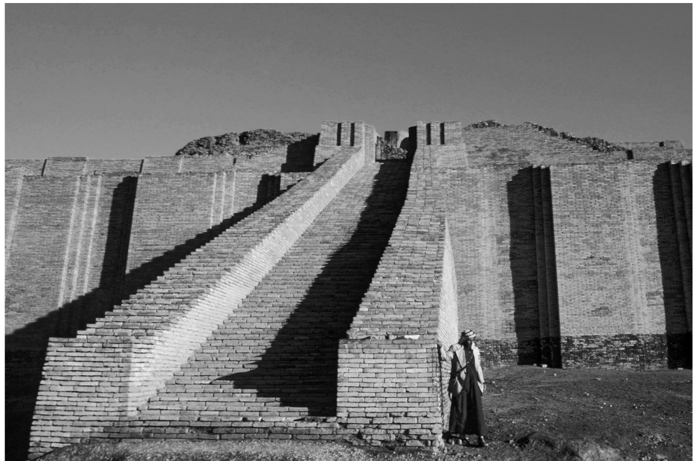
Imagen 05 : Escalera de acceso al Zigurat Fuente: © Copyright - http://www.barbuza.com - Fedora theme by Linethemes
