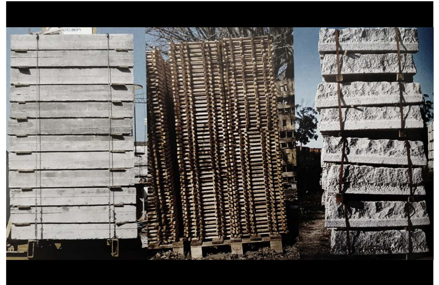
Imagen 02: Eduardo Souto de Moura, Vista del sistema de apilamiento de los materiales en obra Fuente: Eduardo Souto de Moura
