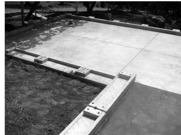
1. Pieza A sobre losa de cimentación
