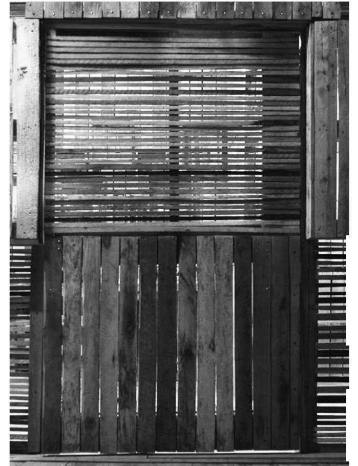
Imagen 54: Disposición de los Palets de madera "Proyecto Chacras" Fuente : Eduardo Cruz y Natura Futura
