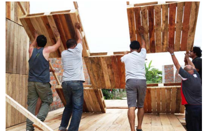
Imagen 57: Montaje de los palets en obra, Natura Futura, "Proyecto Chacras"
