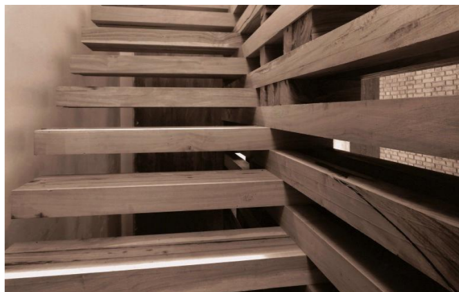
Imagen 25: Vista escalones de Escalera Casa del Grande Fuente: Gustavo Frittegotto, Plataforma Arquitectura
