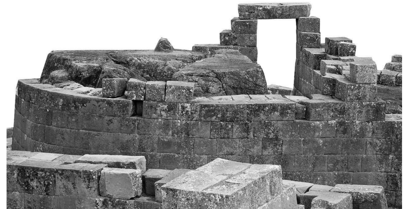
Imagen 09 : Pisac. "Peru_Pisac_Intihuatana Unokorno.jpg. Intihuana". David Stanley, La constante dimensional pasa por la altura de los bloques tallados con caras aproximadamente rectangulares. Al no existir constante dimensional en el ancho la disposición de la traba vertical es aleatoria. Los bloques sufren un ajuste en función de la cara lateral del bloque vecino ya colocado, esto se debe a que no se trabajan las caras con una exacta perpendicularidad".Leblanc. Fuente: Unokorno
