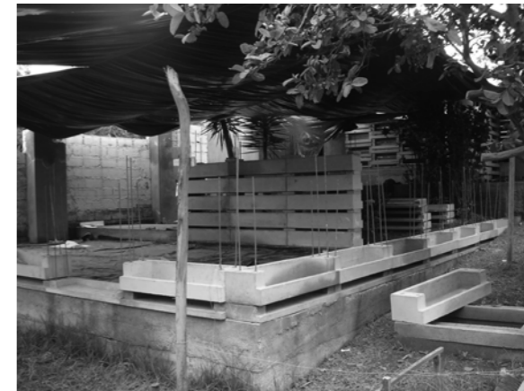
4. Pieza A y B fijadas a losa de cimentación por varillas de acero y masilla epóxica
