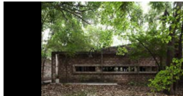
Imagen 154: Fachada Gabinete Arquitectura Fuente: Leonardo Finotti
