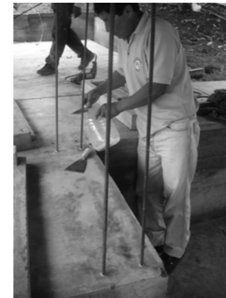
3. Tratamiento previo a instalación de pieza A
