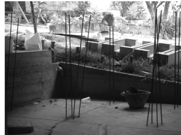
2. Varillas de acero fijadas a losa de cimentación
