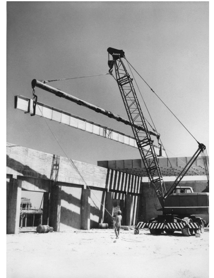
Imagen 04: Instalación de viga Fisac. Fuente: Alex del Río.
