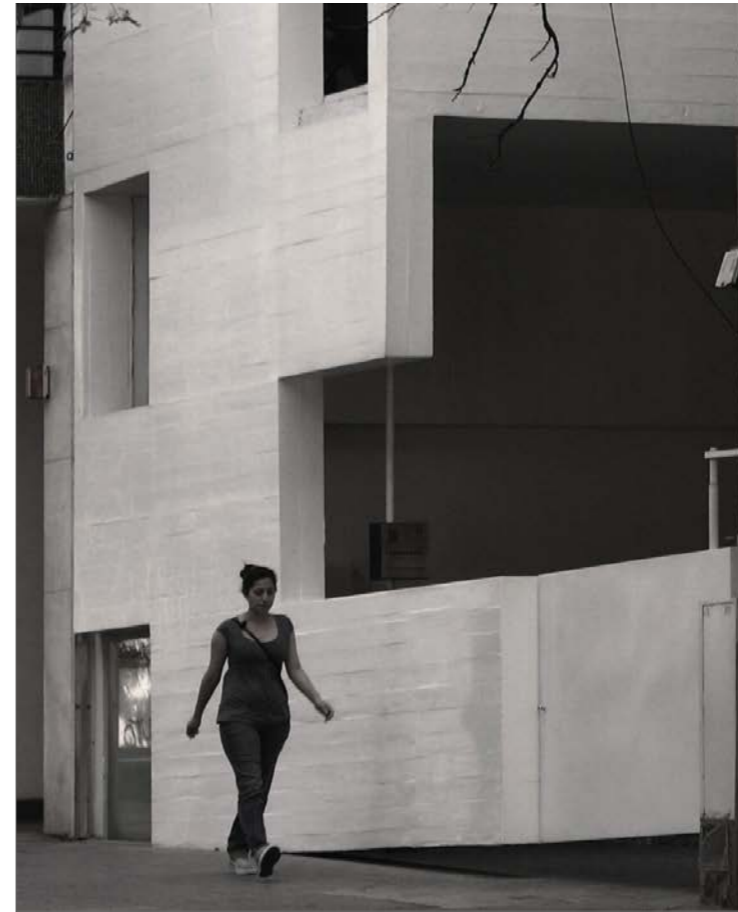
Imagen 57: Perspectiva externa Edificio Altamira / Fuente: Ivan Caorsi,
