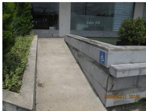
Ilustración 24: Rampa Hotel Zahir 360 Fuente: Autor Fecha: 11 mayo 2018
