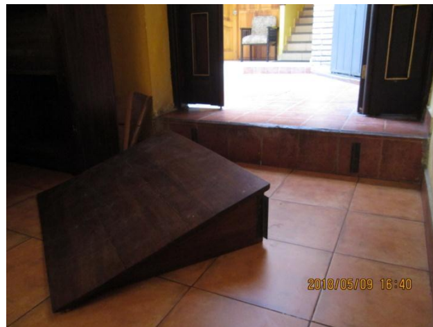
Ilustración 28: Rampa de acceso desmontable, Hotel Los Balcones Fuente: Autor Fecha: 9 mayo 2018
