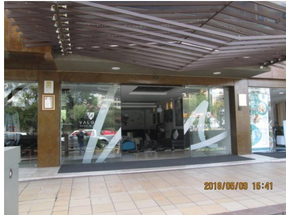
Ilustración 46: Puerta de ingreso, Hotel Valgus Fuente: Autor Fecha: 9 mayo 2018
