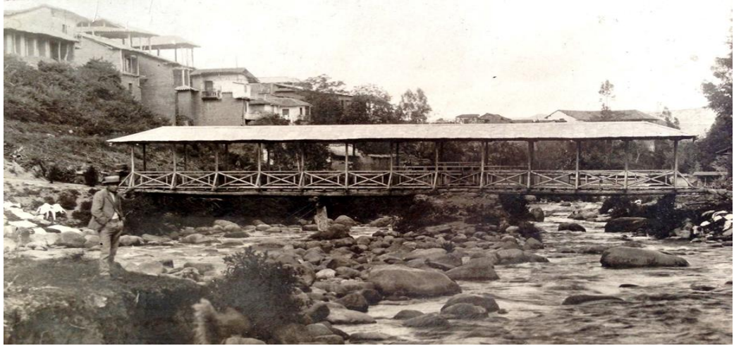
Fig. 59 [Fotografía: anónimo.] (Puente Centenario, construido de madera con techo latón. Parte del puente se asienta en un banco de tierra y le sostiene también una gran viga de madera. El banco de tierra, al parecer era parte de la isleta que se prologaba río arriba en dónde está parado el hombre de sombrero 1900. Archivo del INPC, 2016).
