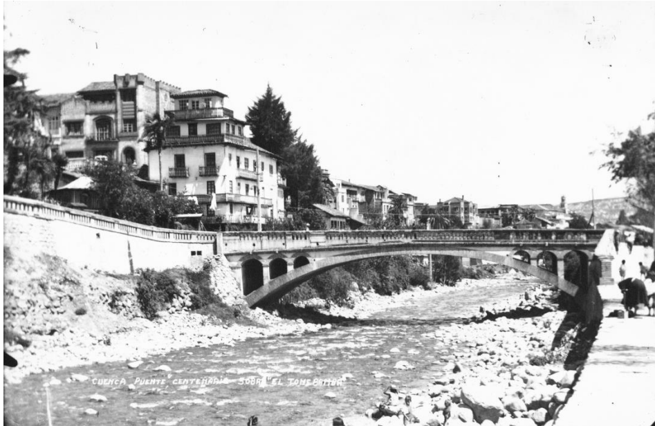
Fig. 64 [Fotografía: Desconocido] (Puente Centenario sobre el río Tomebamba 1914. Archivo del INPC, 2016).
