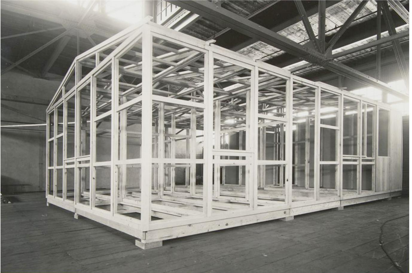
48. Montaje de la estructura de una casa en la fábrica del Panel Universal durante los procesos de estudio, previos a la comercialización. El Panel Universal se compone de una estructura de madera y de los revestimientos, sin embargo, es posible armar el esqueleto de una vivienda sin colocar los cierres.
