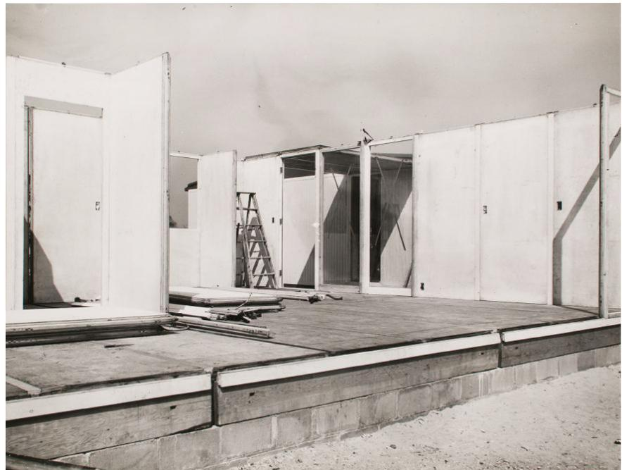
54-55. Proceso de construcción de las casas con el Panel Universal. Las viviendas se colocan sobre una base de bloques para contener las piezas estructurales de madera del piso y realizar la cimentación necesaria.
