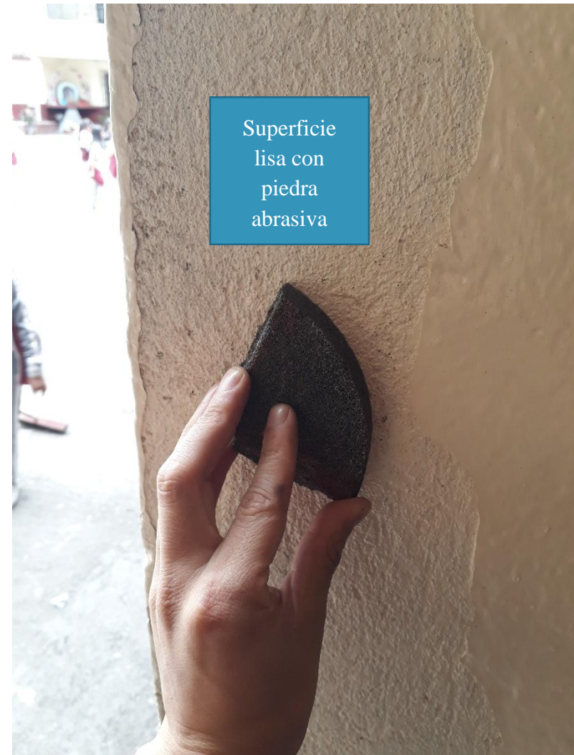
Fotografía 11. Preparación de superficie
