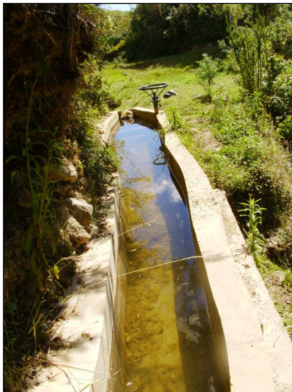
Gráfico 8. Canal del sistema riego (en la captación del sistema)
