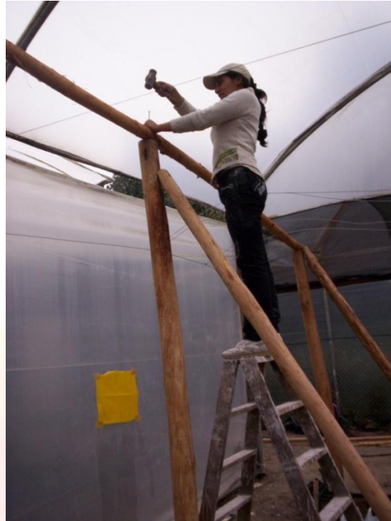
Foto N° 6. Armado de infraestructura para el tutoreo.
