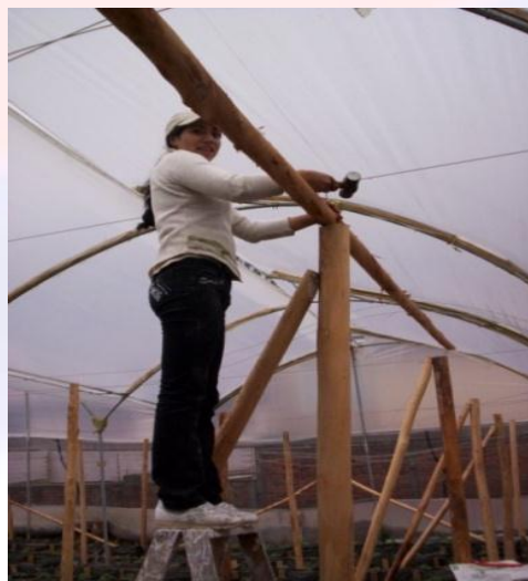
Foto N° 7. Construcción de infraestructura para el tutoreo
