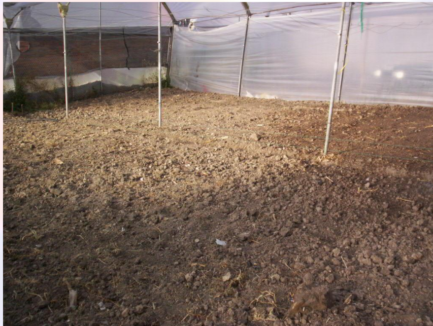
Foto N° 1. Nivelación del terreno.
