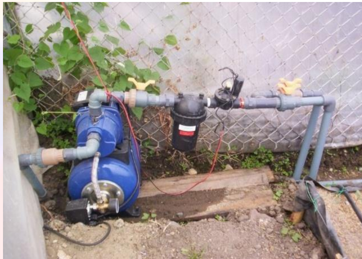
Foto N° 2. Instalación del sistema de riego
