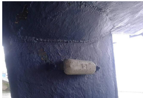
Figura 89. Ánodo de sacrificio como corrección catódica
