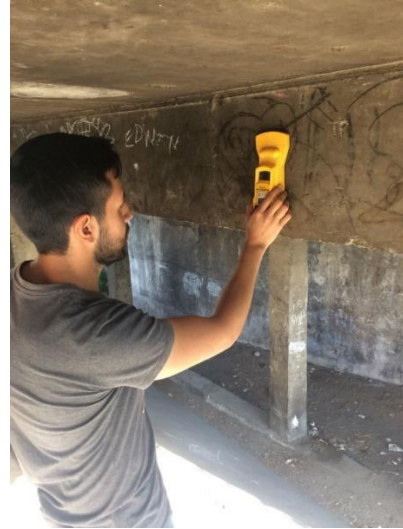
Detección de armadura en Viga 3
