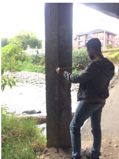
Levantamiento del puente
