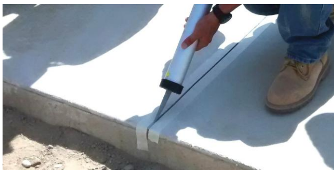
Figura 83. Sellado de junta mediante silicona Fuente: Sikasil (s. f.)
