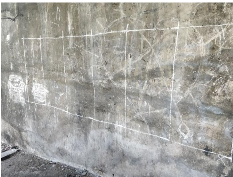
Figura 31. Trazado para el GPR en el estribo derecho
