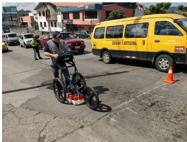
Ensayo de GPR en el tablero
