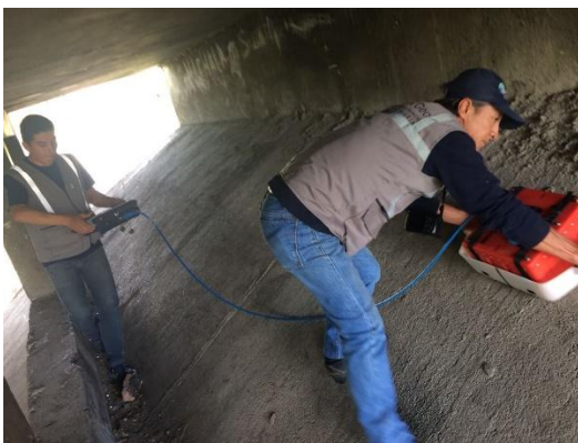
Ensayo de GPR en Arco
