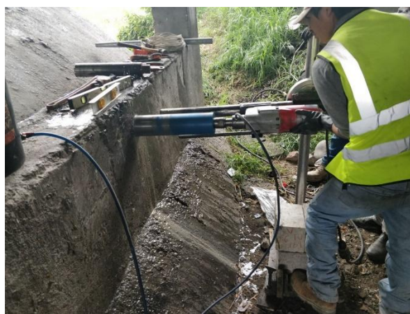
Extracción de núcleo en Viga 2
