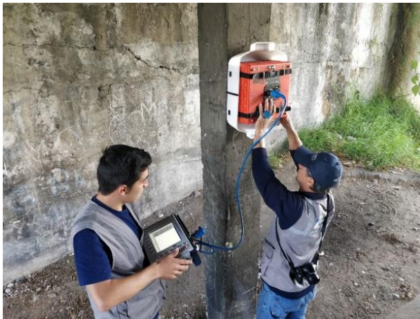
Ensayo de GPR en columna
