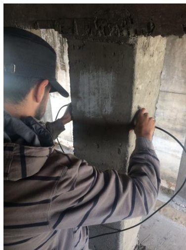
Ensayo de ultrasonido en columna
