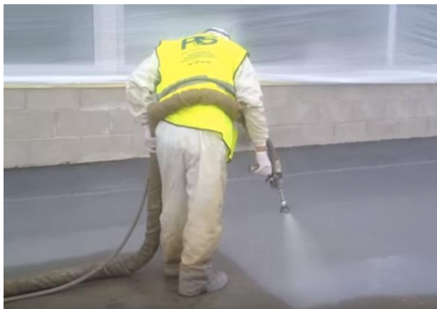
Figura 91. Colocación de membrana de poliuretano en cubierta
