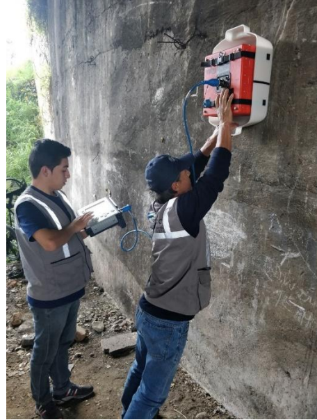
Ensayo de GPR en estribo MD
