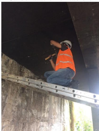
Ensayo de carbonatación en el tablero
