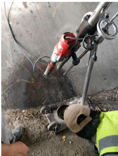
Extracción de núcleos en el arco
