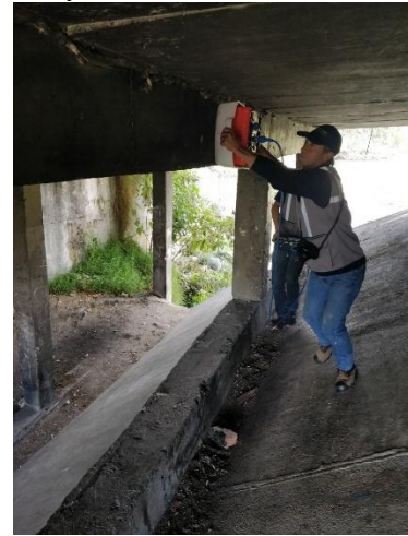
Ensayo de GPR en Viga 3
