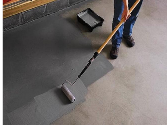
Figura 88. Pintura acrílica colocada en piso
