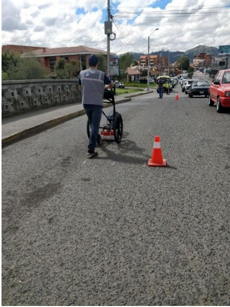
Ensayo de GPR en el tablero
