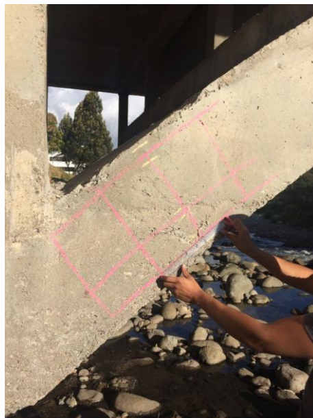
Figura 29. Ubicación del acero en el arco.
