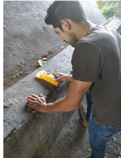
Detección de armadura en Viga 2
