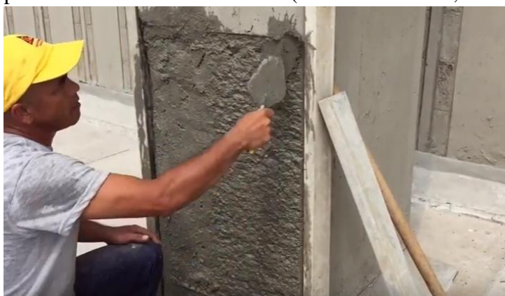
Figura 87. Colocación de mortero modificado con polímeros en columna Fuente: Expecorn (2015)
