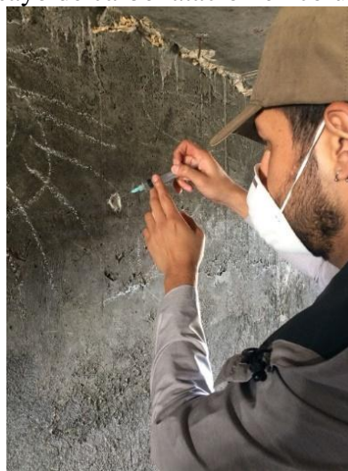
Ensayo de carbonatación en diafragma
