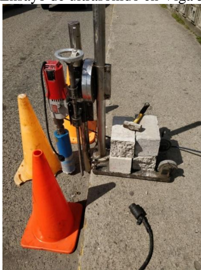
Montaje de extractor en el tablero
