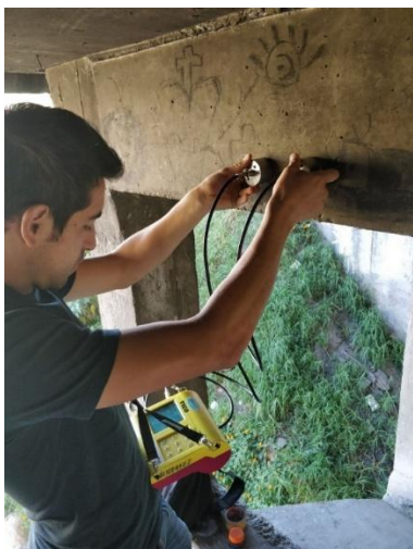
Ensayo de ultrasonido en Viga 3
