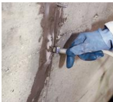
Figura 79. Inyección de microcemento en muro
