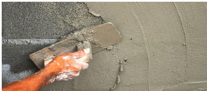
Figura 81. Colocación de mortero grout Fuente: "Mortero preparado" (s. f.)
