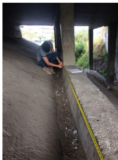
Levantamiento del puente
