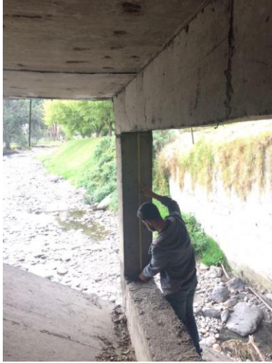
Levantamiento del puente
