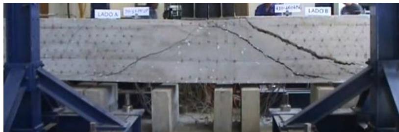
Figura 12. Falla de viga a cortante.
