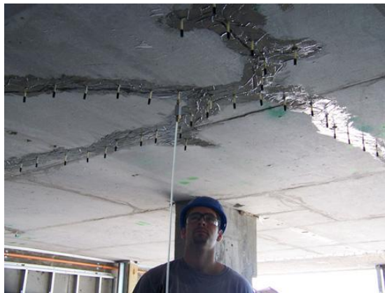
Figura 85. Inyección de resina de epoxi en losa. Fuente: "Reparación de grietas y fisuras de casas" (s. f.)
