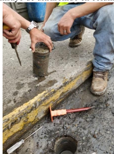
Extracción de núcleo en el tablero
