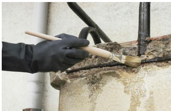
Figura 86. Colocación de pasivante a base de resinas Fuente: Beissier (2018)
