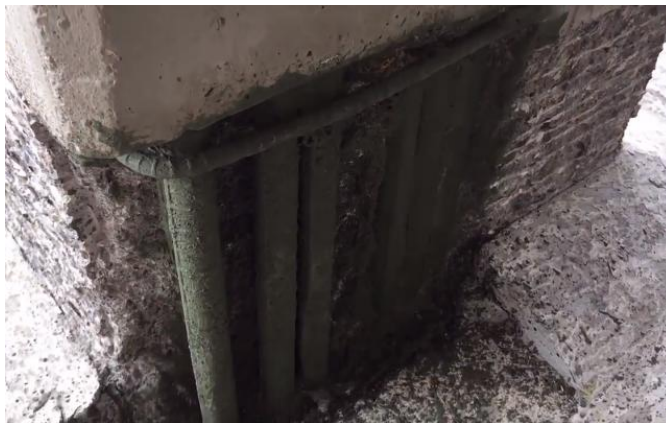
Figura 80. Aplicación de inhibidor de corrosión en columna Fuente: Expecorn (2015)
