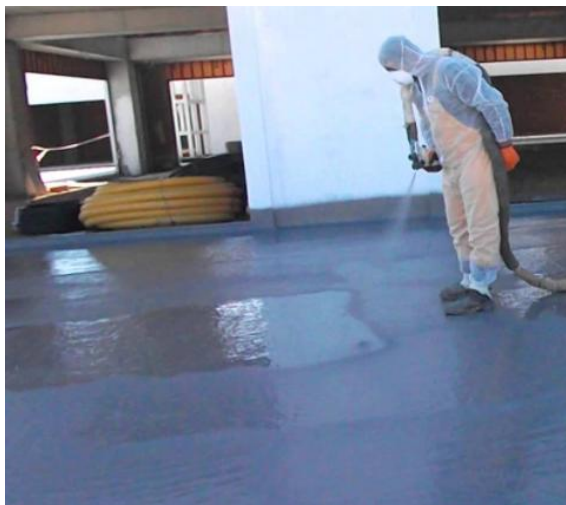
Figura 82. Colocación de poliúrea como revestimiento Fuente: Rawlins Paints (2017)
