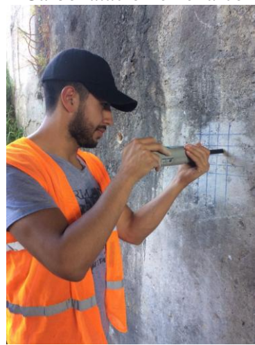
Ensayo de esclerometría en estribo
