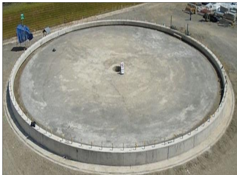
Figura 1.6 Losa de cimentación circular.
