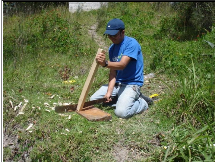
Foto 11. Preparación de materiales para la instalación de las obras de conservación 2008. Pesántez P, Seminario M.
