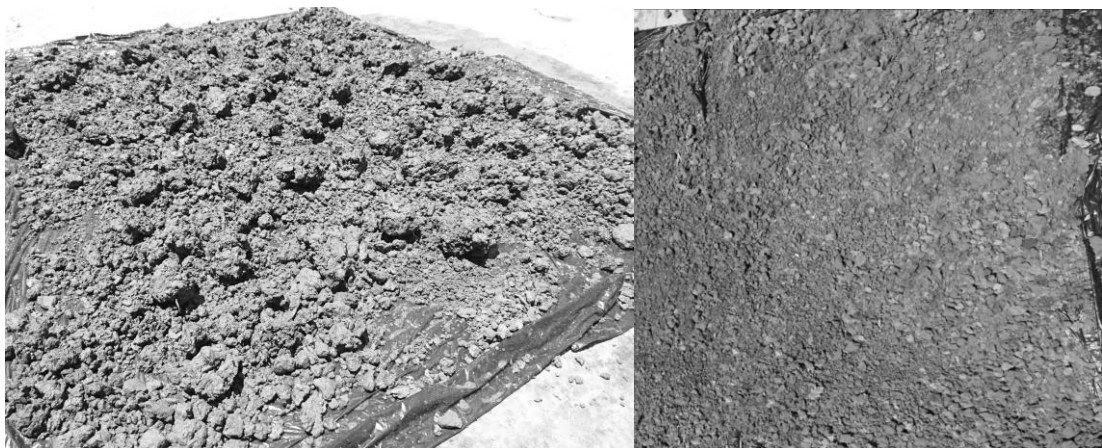
PERALTA JORGE, 2017, Tendido de Material Lodo de Tixán. [Imagen 33]
