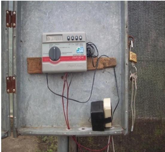
**Foto N° 20.** Programador de Riego (TIMER)
