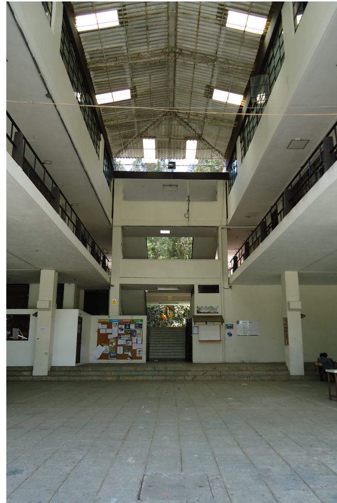
Imagen 29 Vista zona central del vestíbulo (Venegas, 2016)
