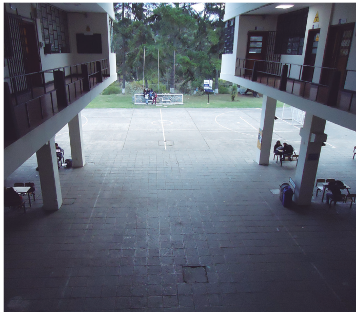
Imagen 33 Vista central del vestíbulo (Venegas, 2016)
