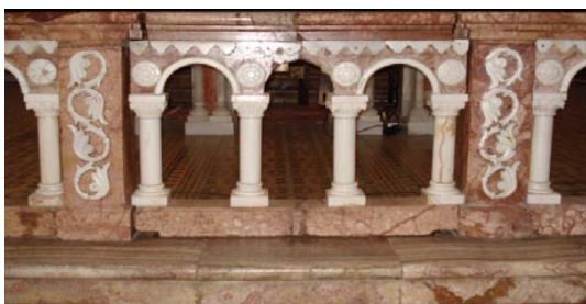
(Ilustraciones 9y 10: Altar de la iglesia de Santo Domingo (2007). Detalle del acceso al altar (2007), Fuente: los autores).
