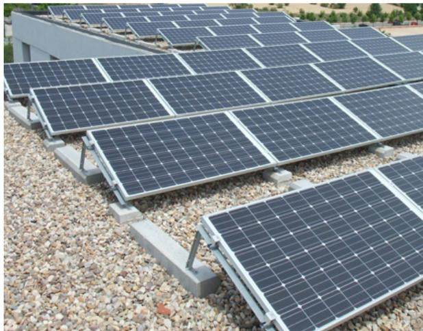
38. Sistema de fijación en cubierta plana de módulos PV.
