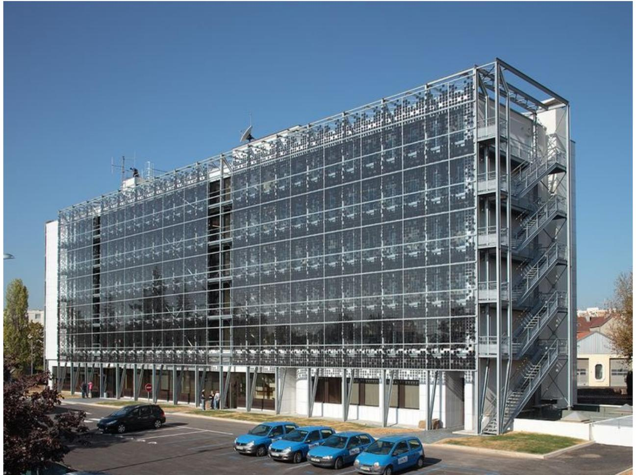
43. El edificio GDF Seuz, en Francia, utiliza una sobre fachada que tiene la función de protección solar y a la vez genera energía PV.
