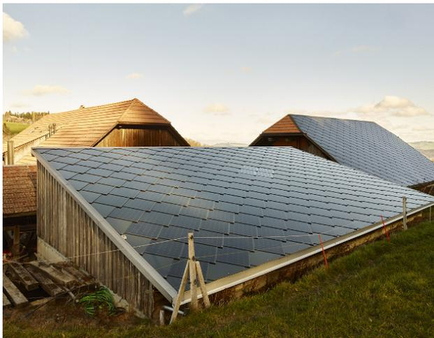
32. Colectores PV integrados arquitectónicamente.
