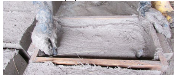
Figura 90. Ubicación de varillas (primera capa) Fuente: Elaboración propia
