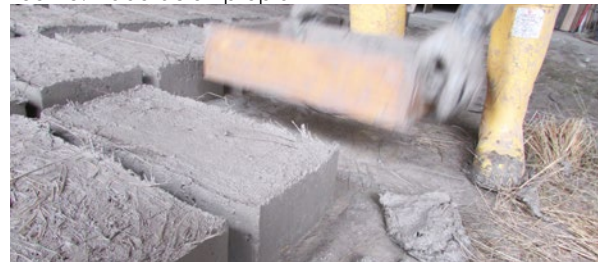
Figura 98. Desmolde del adobe Fuente: Elaboración propia
