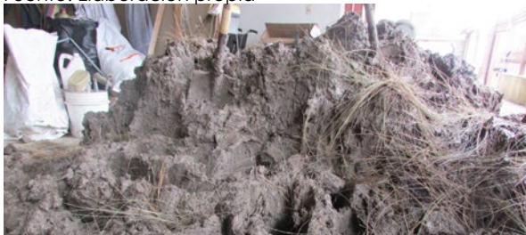
Figura 37. Mezclado de la tierra Fuente: Elaboración propia
