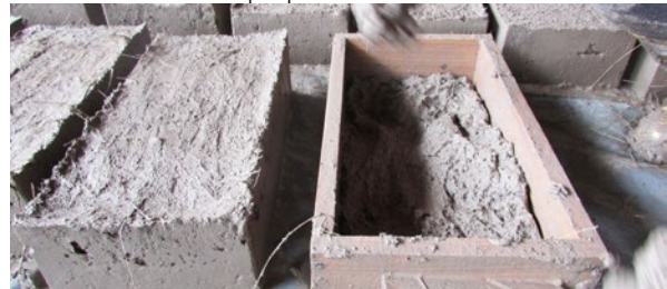
Figura 84. Colocación de la primera capa Fuente: Elaboración propia
