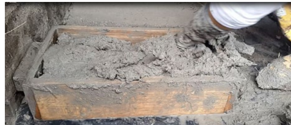
Figura 96. Colocación de la mezcla Fuente: Elaboración propia
