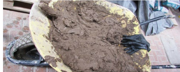
Figura 59. Preparación del mortero Fuente: Elaboración propia
