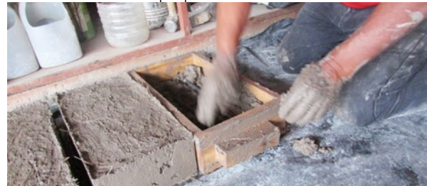
Figura 72. Colocación de la primera capa Fuente: Elaboración propia
