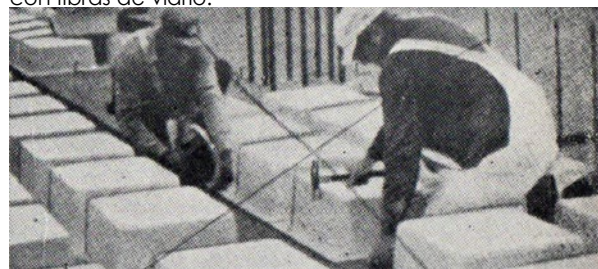
Figura 16. Encofrado de resina poliéster-fibra vidrio. Fuente: D'Arzié, Duilio. (1977). Los plásticos reforzados con fibras de vidrio.
