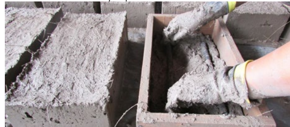
Figura 78. Ubicación de varillas (primera capa) Fuente: Elaboración propia
