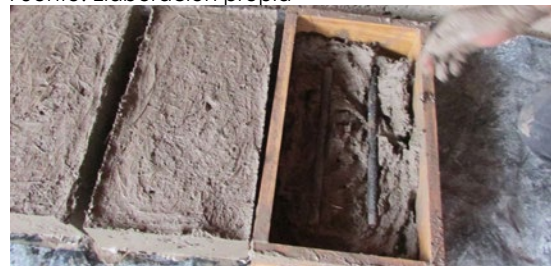
Figura 73. Ubicación de las varillas Fuente: Elaboración propia
