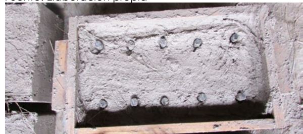
Figura 91. Ubicación de varillas (segunda capa) Fuente: Elaboración propia
