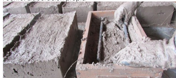
Figura 79. Ubicación de varillas (segunda capa) Fuente: Elaboración propia
