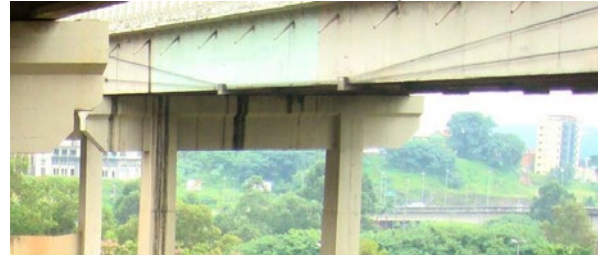
Figura 10. Pretensado exterior. Fuente: https://www.structuralia.com/mx/blog/24-construccion
