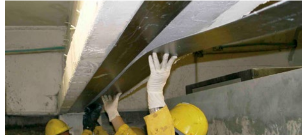
Figura 9. Refuerzo con lámina metálica. Fuente: https://www.structuralia.com/mx/blog/24-construccion
