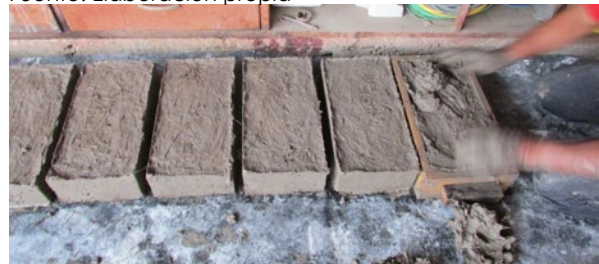
Figura 40. Moldeo de los adobes Fuente: Elaboración propia
