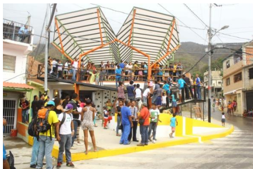
Figura 6: Colectivo de Arquitectura Pública Asamblearia (CAPA). Construcción de Espacio de Paz en el barrio Valle del Pino del Estado Vargas de la República Bolivariana de Venezuela, 2015
