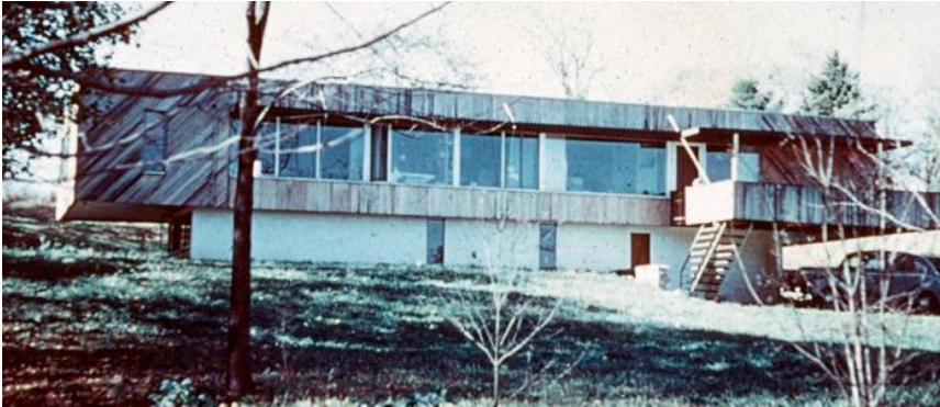
Figura 46. Los materiales predominantes de esta obra fueron: hormigón, piedra, madera, aluminio y vidrio. Fuente: Marcel Breuer. Digital Archive
