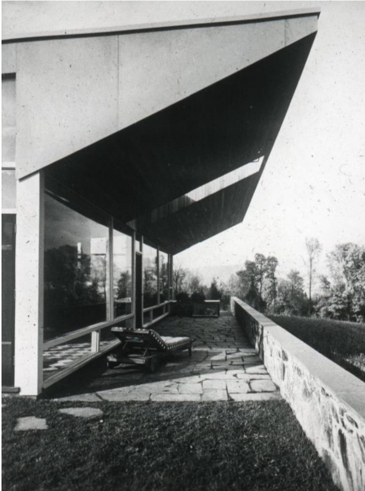
Figura 28. Vista del porche. Fuente: Marcel Breuer Digital Archive.
