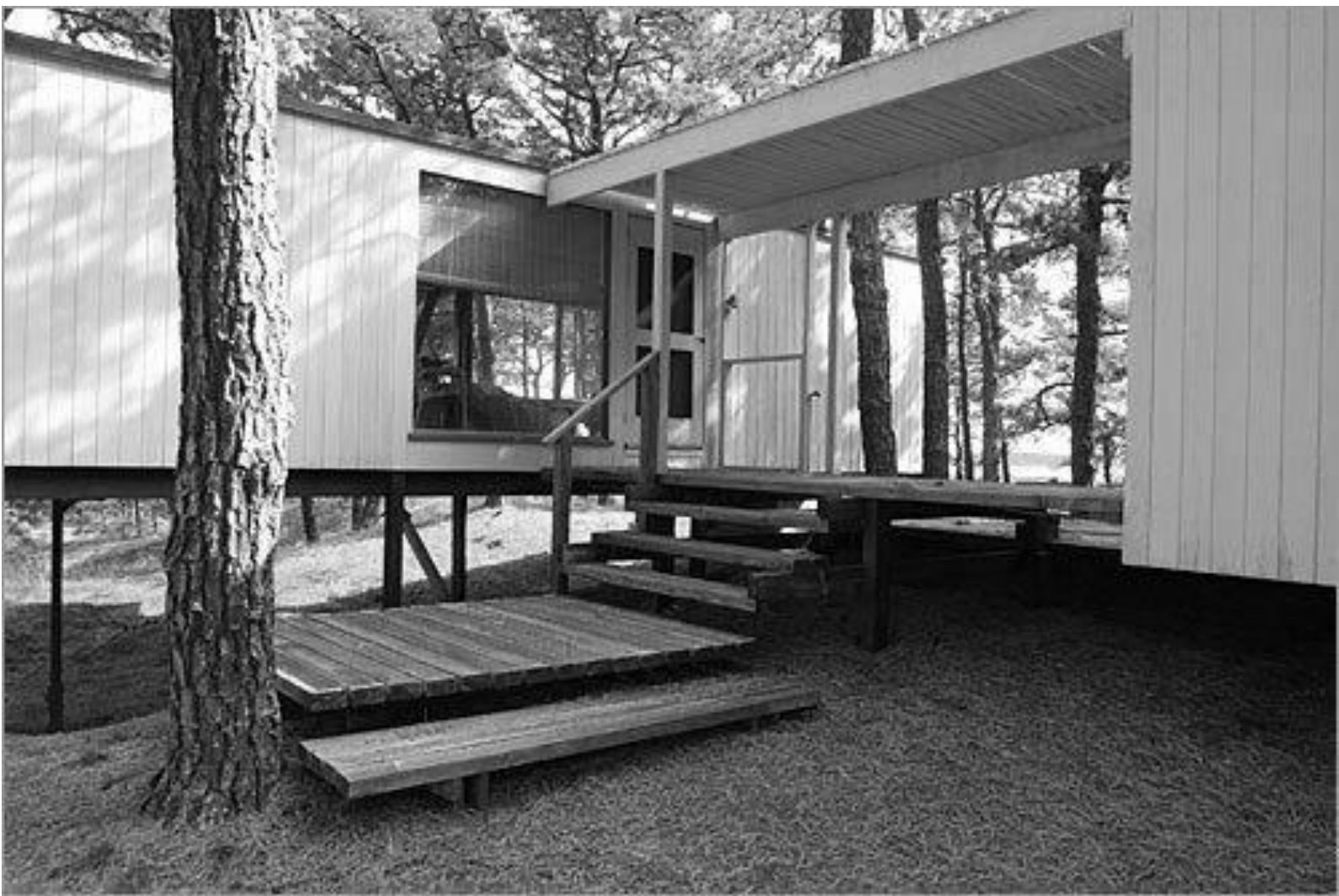
Figura 71. Vista hacia el Porche desde el acceso: Marcel Breuer Wise Cottage.
