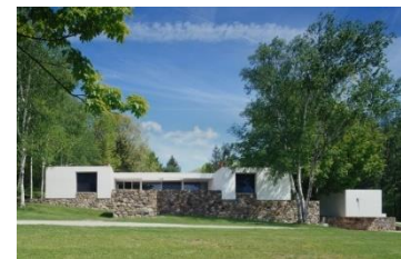
Figura 38. Los materiales predominantes de esta obra fueron: hormigón, piedra, estuco, aluminio y vidrio. Fuente: Marcel Breuer. Digital Archive
