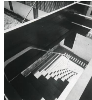
figura 53. Escaleras que conectan el porche inferior con la terraza. Fuente. Marcel Breuer. Digital Archive
