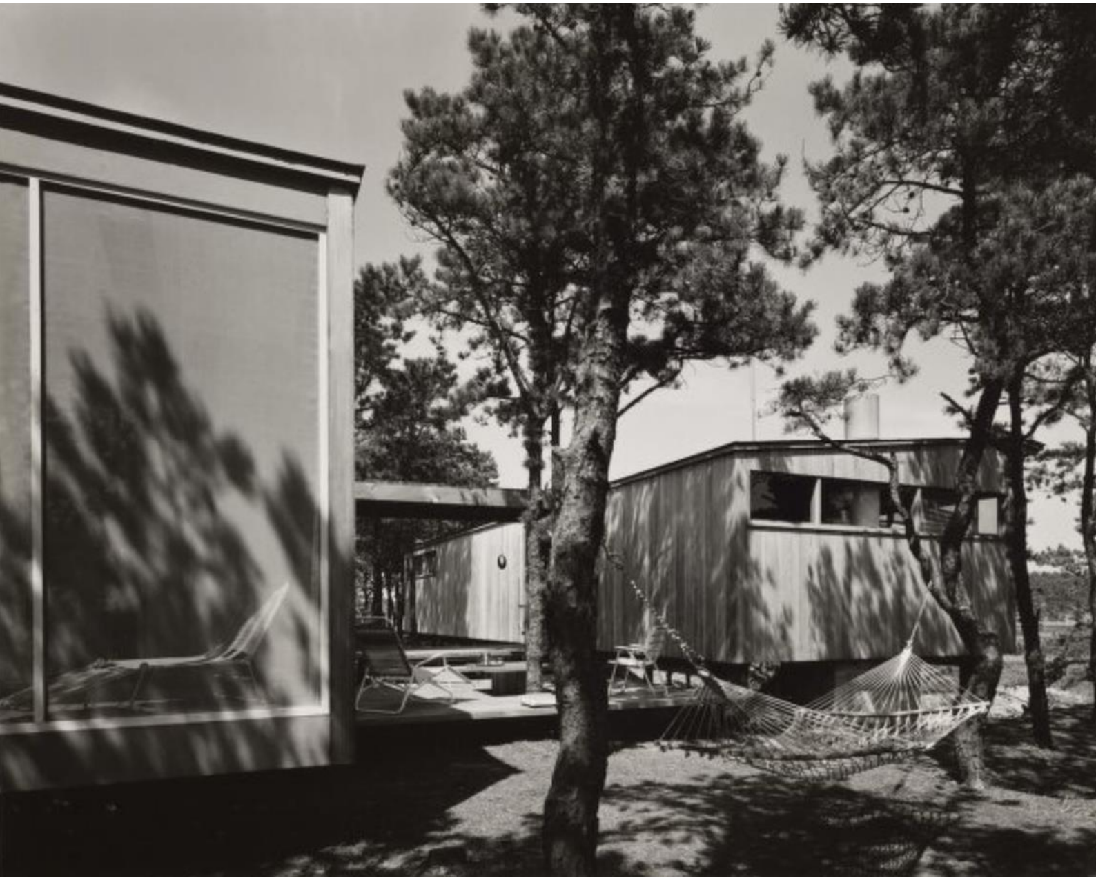
Figura 76 Vista hacia el Porche desde el Sur: Marcel Breuer Wise Cottage.
