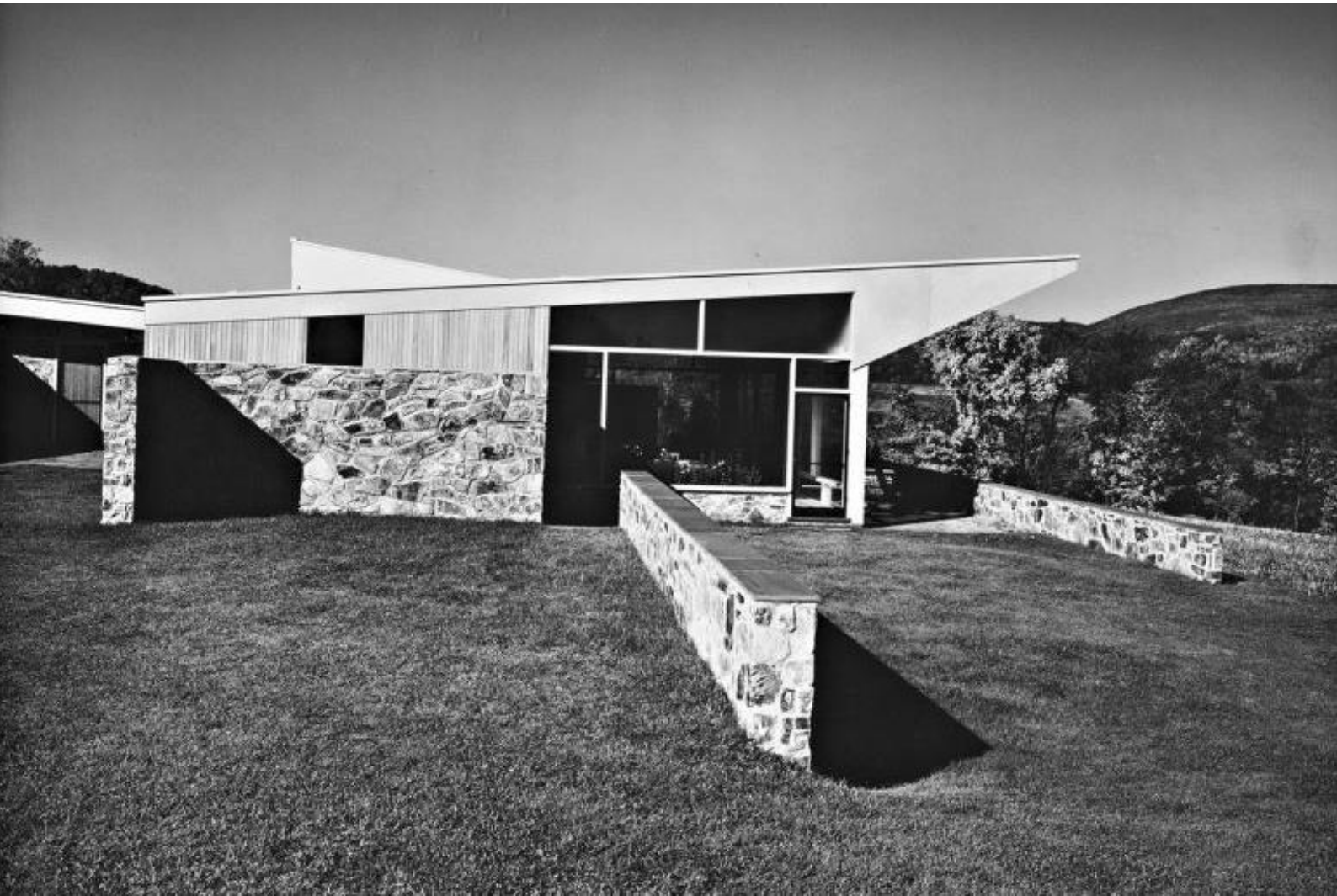
Figura 73. Vista sur de la casa, muros paralelos. Fuente: Marcel Breuer. Digital Archive
