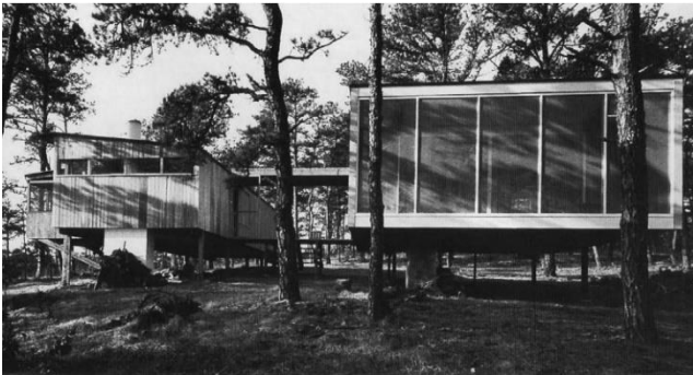
Figura 11. Vista del proyecto cottage Breuer tras la ampliación de 1961. Fuente: El lugar del fuego en la arquitectura de Marcel Breuer .
