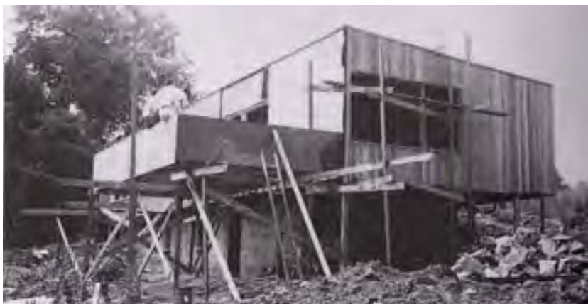
Figura 37. Vista del Porche. Fuente: Marcel Breuer. Digital Archive
