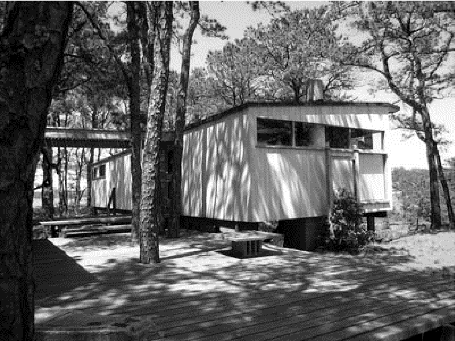
Figura 75. Vista desde el ágora hacia el Porche de: Marcel Breuer Wise Cottage.
