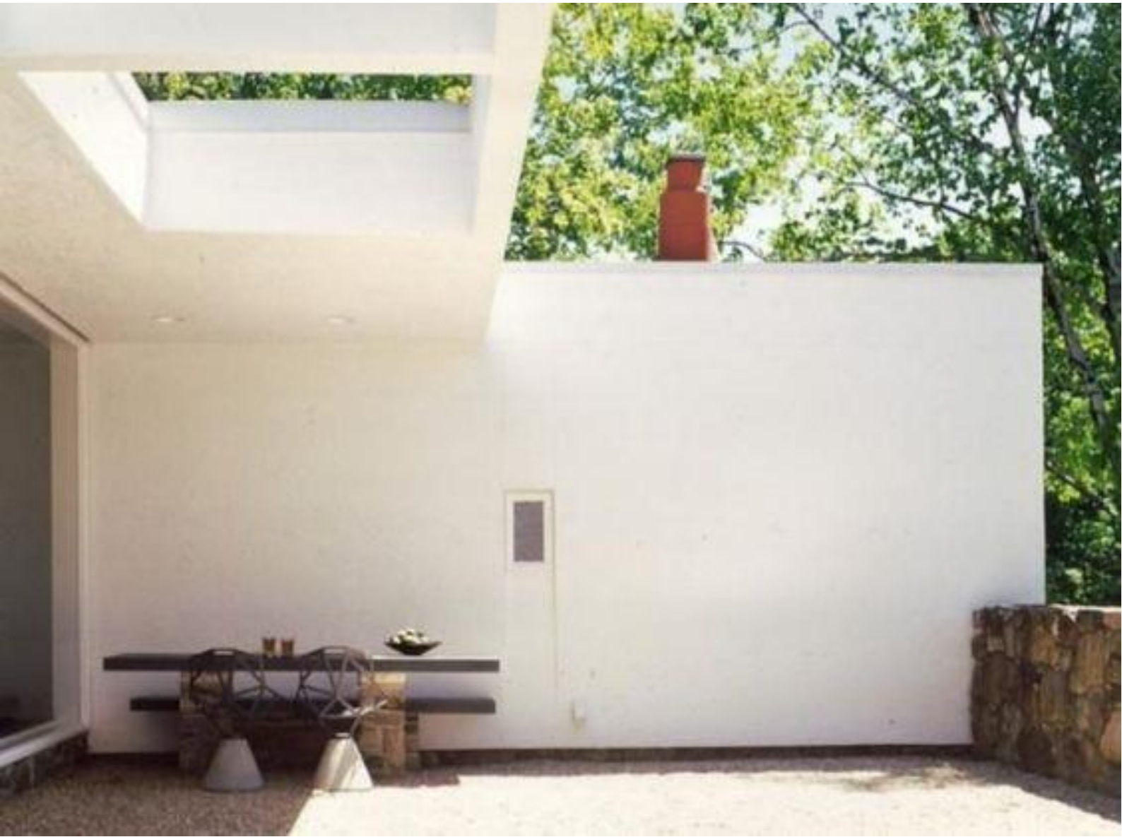
Figura 66. Vista del porche. Fuente: MARCEL BREUER, 1964-1965 STILLMAN II
