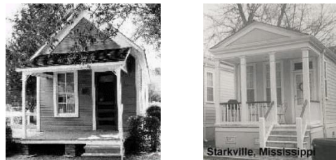
Figura 9-10. casas escopeta restaurados en el Sur, en la actualidad. Fuente: The American front Porch
