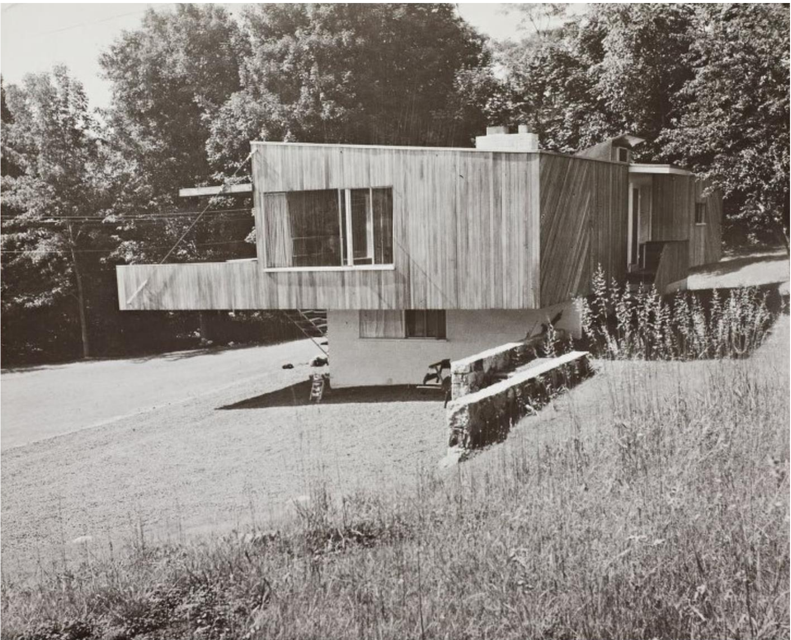
Figura 81. Vista general de la casa en donde predomina el volado de la terraza y el Porche paralelo a éste: Marcel Breuer. Digital Archive
