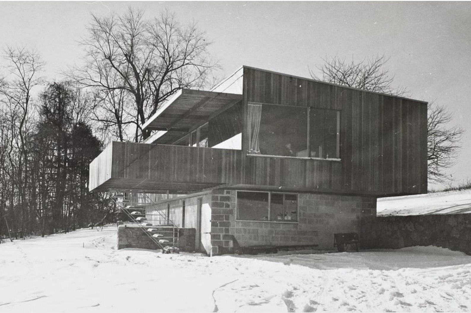
Figura 84. Vista de la casa desde el Noreste. Fuente: Marcel Breuer. Digital Archive.
