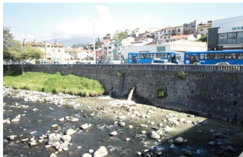
Ilustración 85: Red de Interceptores construidos a lo largo de las márgenes de los ríos de la Ciudad de Cuenca hasta el 2015/ Fuente: GAD Municipal del Cantón Cuenca (ETAPA EP.)
