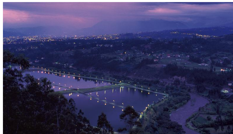
Ilustración 87: Vista Nocturna de la Planta de Tratamiento de Aguas Residuales/ Fuente: GAD Municipal del Cantón Cuenca (Dirección de Planificación)
