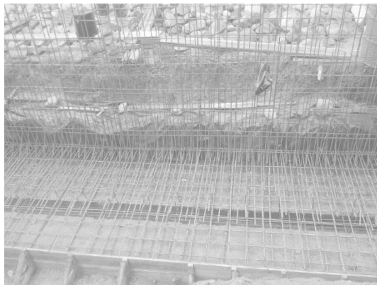
Zapata y pantalla de muro
