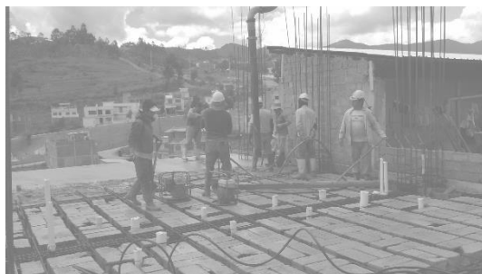
Fundición de losa
