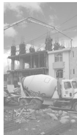
Fundición de columnas de nivel 4
