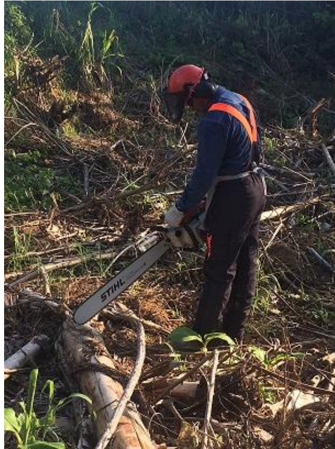
Imagen 14: Desbroce de maleza. Fuente: Autor
