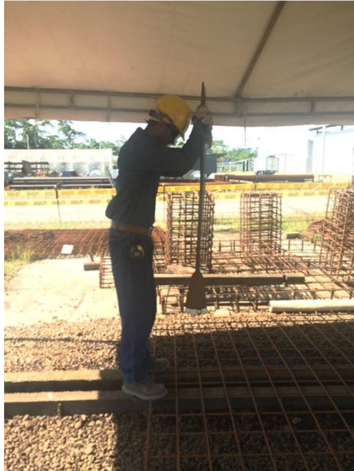
Imagen 12: Doblado manual de malla de hierro. Fuente: Autor
