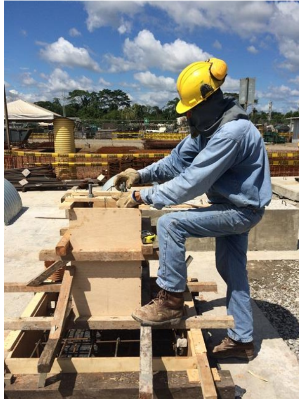
Imagen 4: Encofrado de estructura. Fuente: Autor
