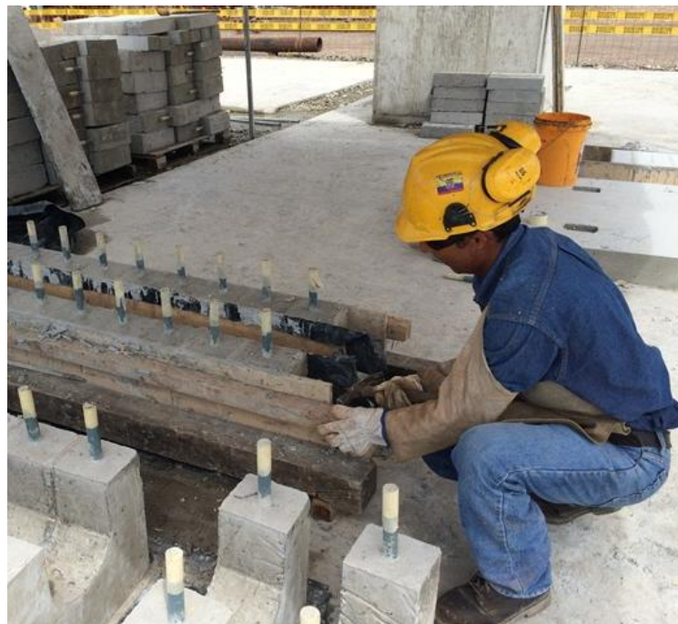
Imagen 8: Tarea desencofrado. Fuente: Autor
