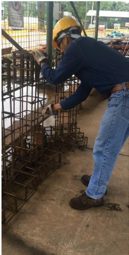
Imagen 10: Amarrado manual de varilla. Fuente: Autor
