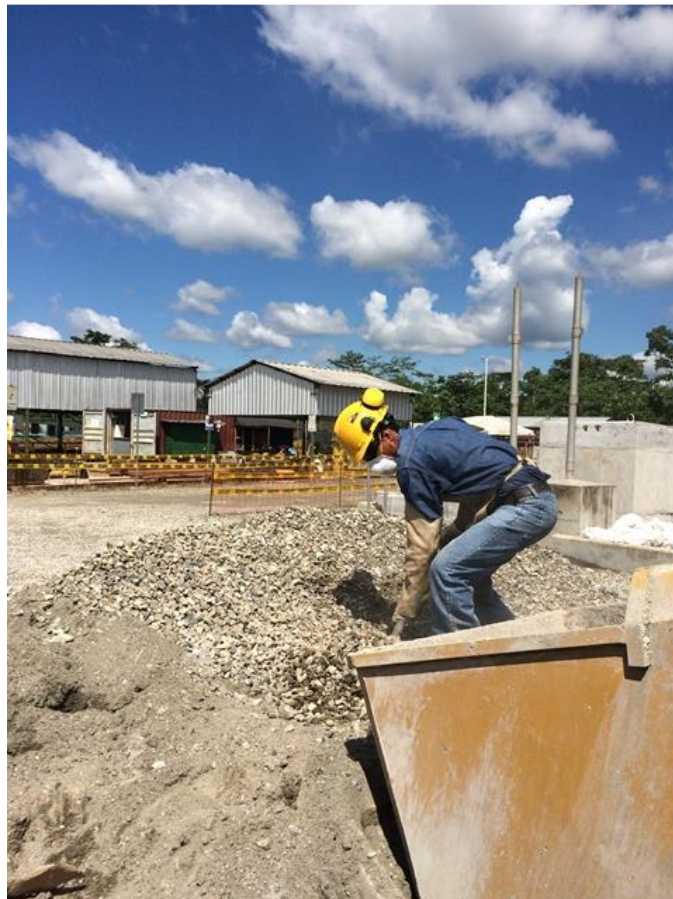
Imagen 6: Paleado de material para hormigonado. Fuente: Autor
