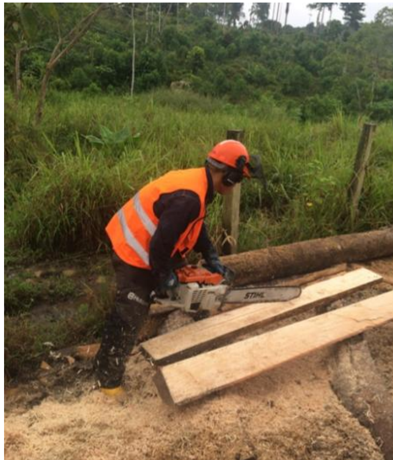
Imagen 16: Aserrado de estacas. Fuente: Autor
