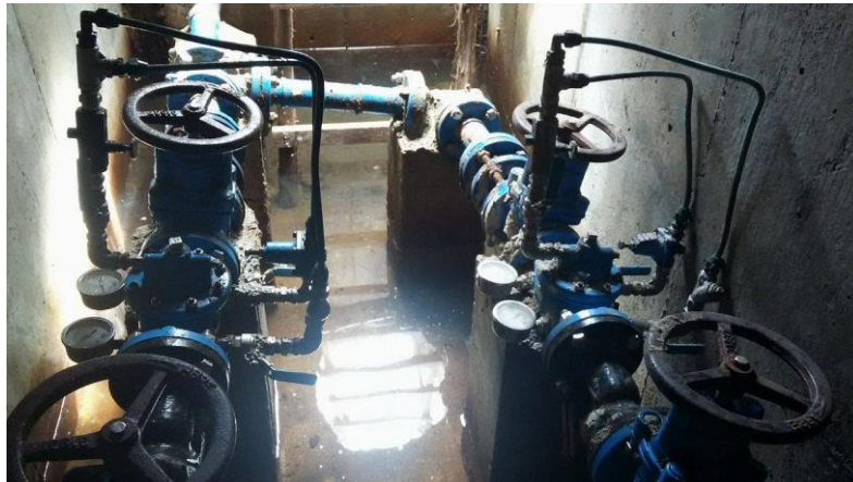
Anexo 13. Estación reductora de presión
