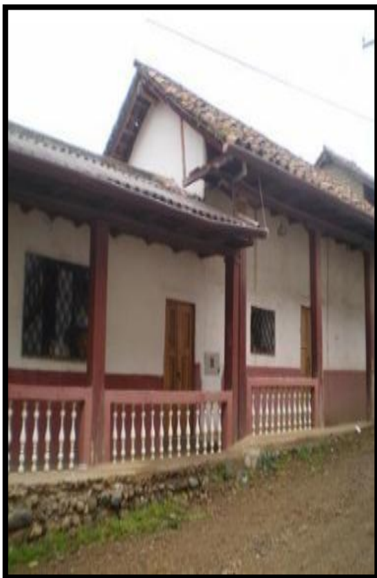
Fotografía 193 Título: Vivienda # 39 de estilo Colonial Fuente: Instituto Nacional de Patrimonio Cultural Fecha: Agosto del 2017
