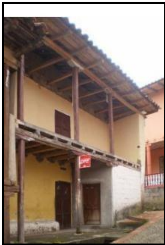
Fotografía 185 Título: Vivienda # 35 de estilo Colonial Fuente: Instituto Nacional de Patrimonio Cultural Fecha: Agosto del 2017
