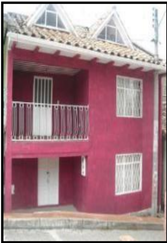
Fotografía 203 Título: Vivienda # 44 de estilo Colonial Fuente: Instituto Nacional de Patrimonio Cultural Fecha: Agosto del 2017
