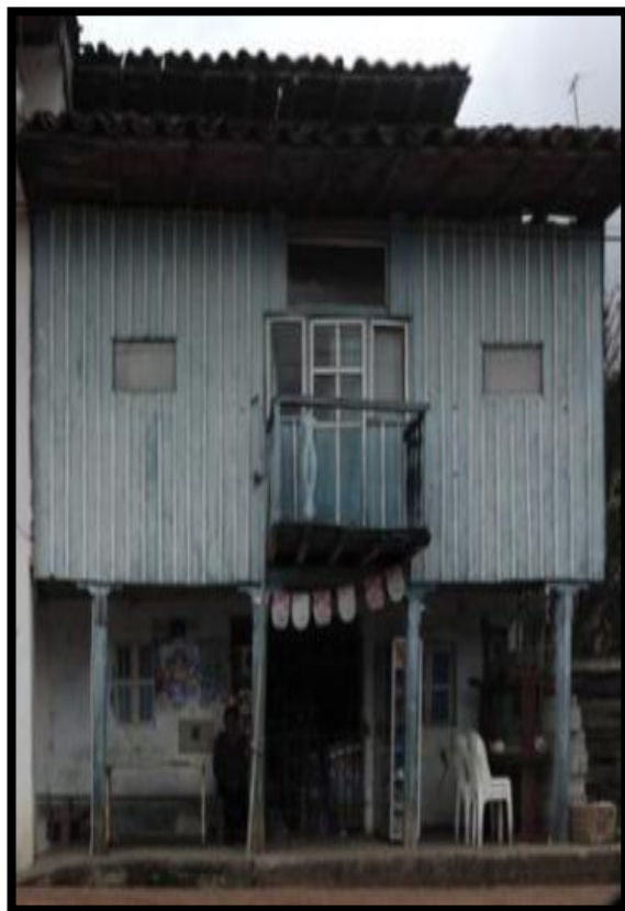
Fotografía 199 Título: Vivienda # 42 de estilo Colonial Fuente: Instituto Nacional de Patrimonio Cultural Fecha: Agosto del 2017
