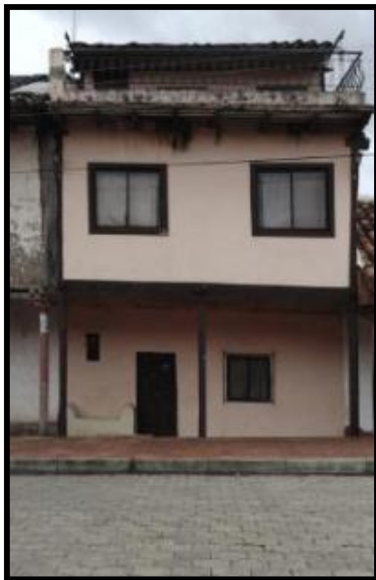
Fotografía 197 Título: Vivienda # 41 de estilo Colonial Fuente: Instituto Nacional de Patrimonio Cultural Fecha: Agosto del 2017
