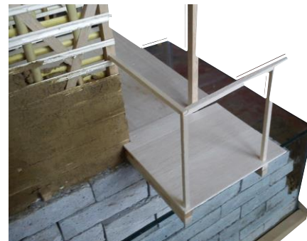
Foto 8. Proceso constructivo del modelo de vivienda vernácula de bahareque. Autor: Paúl Rivas Rivas.
