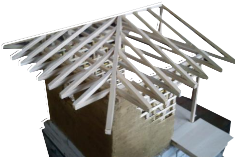
Foto 8. Proceso constructivo del modelo de vivienda vernácula de bahareque. Autor: Paúl Rivas Rivas.
