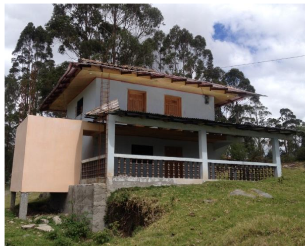
Foto 11. Viviendas vernáculas con cambios de materiales de la parroquia Cojitambo. Autor: Paúl Rivas Rivas.
