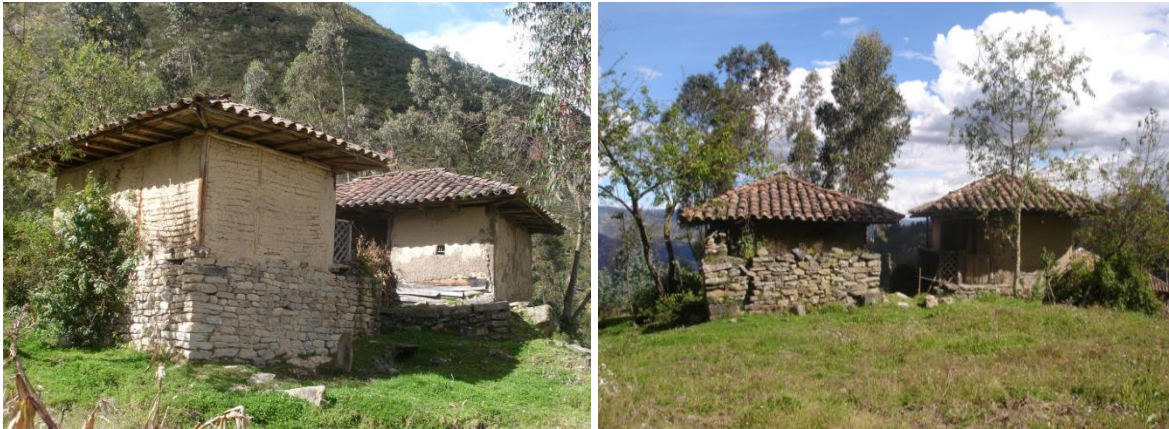
Foto 5. Viviendas de bahareque de la parroquia Cojitambo, en buen estado. Autor: Paúl Rivas Rivas.
