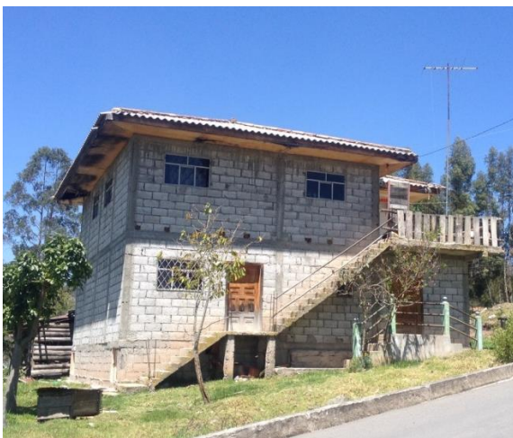
Foto 11. Viviendas vernáculas con cambios de materiales de la parroquia Cojitambo. Autor: Paúl Rivas Rivas.
