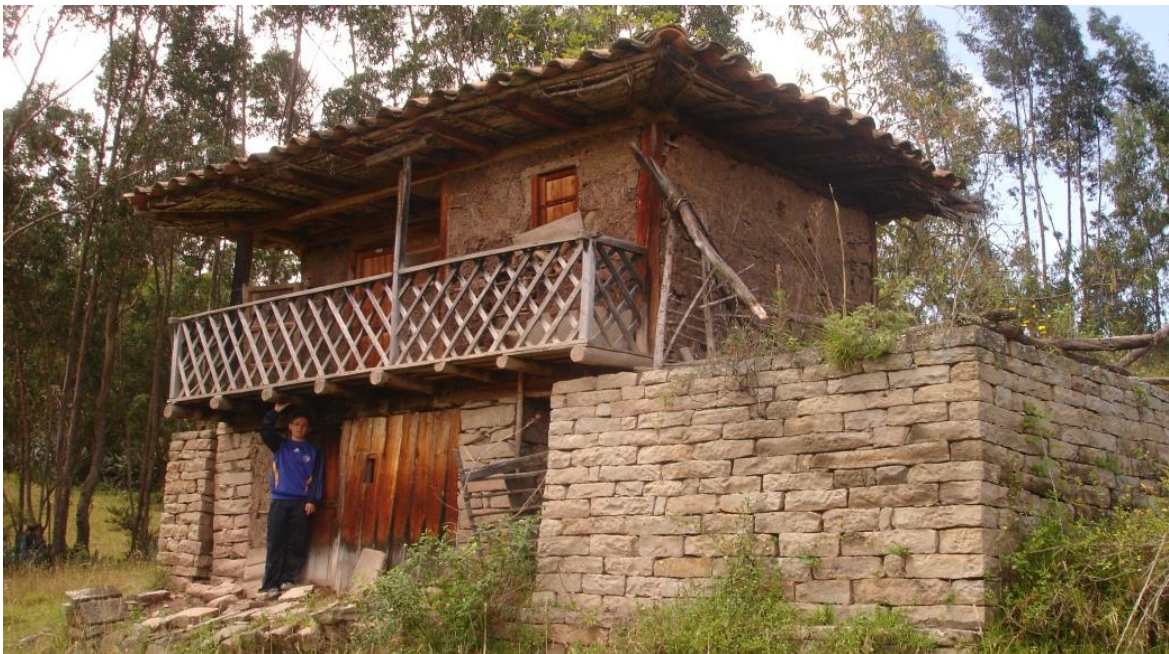
Foto 6. Vivienda de bahareque de la parroquia Cojitambo, en buen estado. Autor: Paúl Rivas Rivas.
