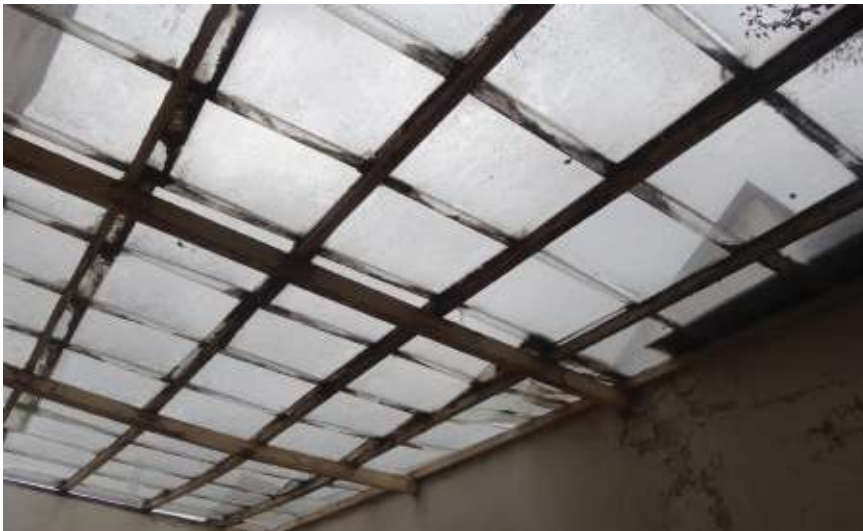
Figura 66: Pozo de luz de la caja de escaleras en la casa Guerrero Palacios, previo a la intervención Fuente: Proyecto vIirCPM, 2013
