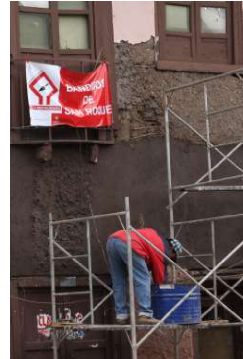
Figuras 45 y 46: Intervención en la fachada de la edificación 05 Fuente: Equipo San Roque, 2014
