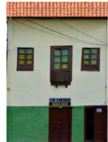
Figuras 43 y 44: Edificación 05, antes y después de la intervención Fuente: Equipo San Roque, 2014
