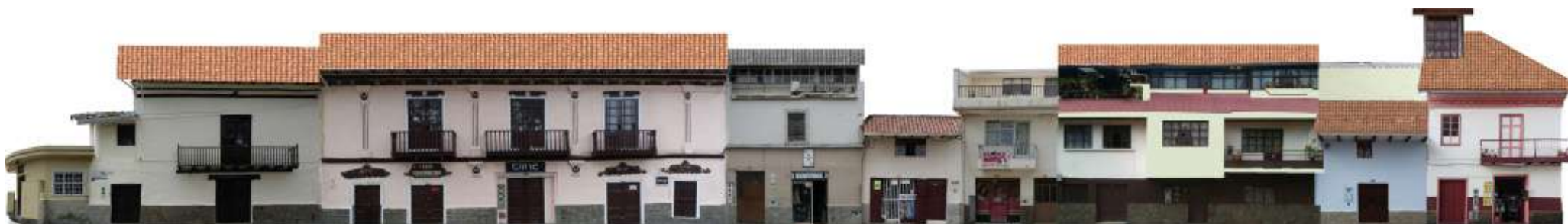
Figura 30: Tramo de la avenida 12 de Abril, cromática después de la intervención / Fuente: Equipo San Roque, 2014
