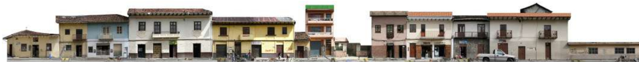
Figura 33: Tramo de la avenida Loja, cromática antes de la intervención / Fuente: Taller Integral de Conservación de Patrimonio, 2013
