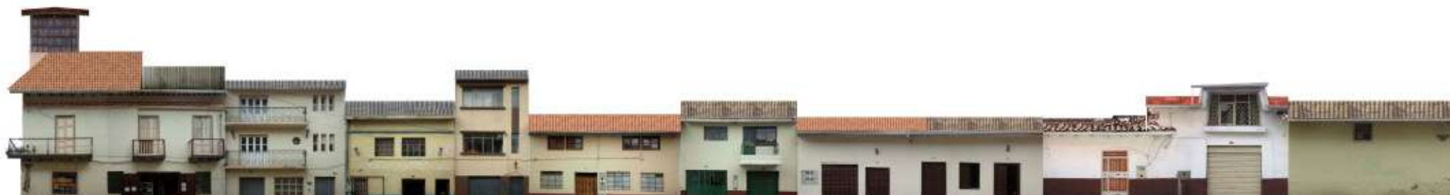
Figura 31: Tramo de la calle de El Farol, cromática antes de la intervención / Fuente: Taller Integral de Conservación de Patrimonio, 2013
