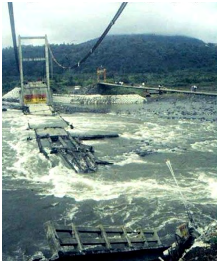
Fotografía N° 1.24. Caída del puente sobre el río Upano, 1995.
