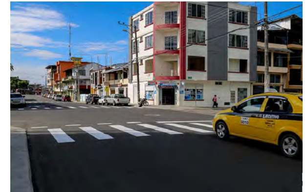
Fotografía N° 3.45. VIALIDAD: Señalización horizontal.
