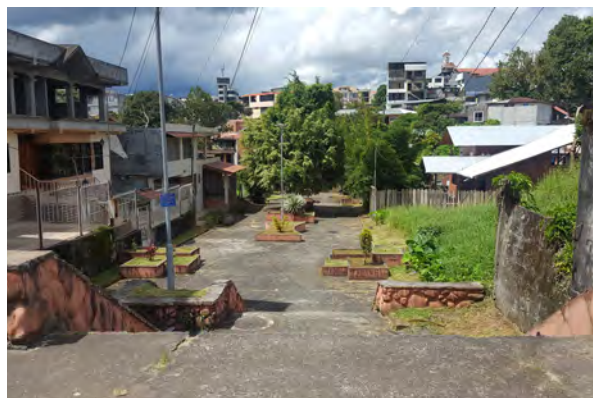
Fotografía N° 1.28 Estado actual del pasaje Los Canelos.
