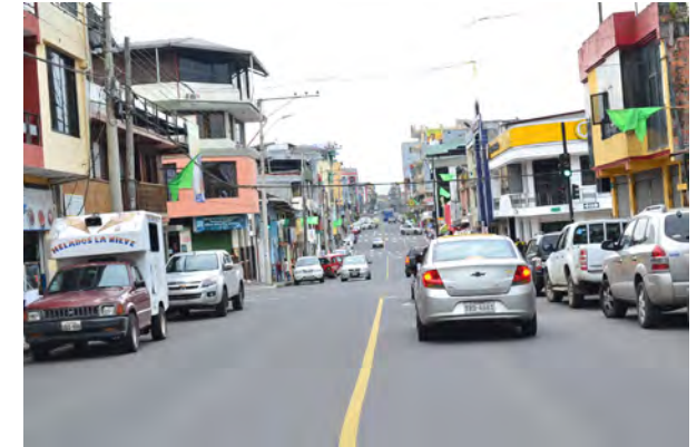
Fotografía N° 3.37. VIALIDAD: Calle Soasty.
