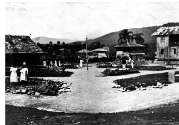
Fotografía N° 2.23. Construcción del parque de la Amazonía. Año 1963.
