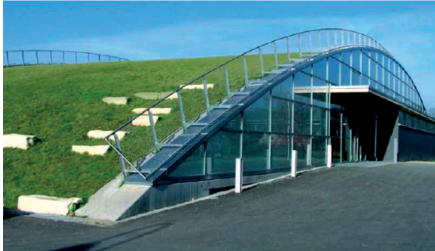
Ilustración 4. Cubierta del Gimnasio Clara Grunewald en Friburgo Alemania Fuente Revista Zinco (Zinco, 2009)
