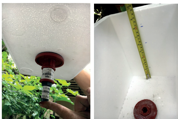
Ilustración 39. Sistema de desagüe para evacuación de aguas lluvias (Fuente Propia)
