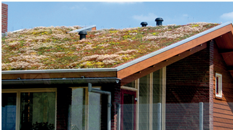
Ilustración 22. Cubiertas verdes extensiva (Zinco 2009).
