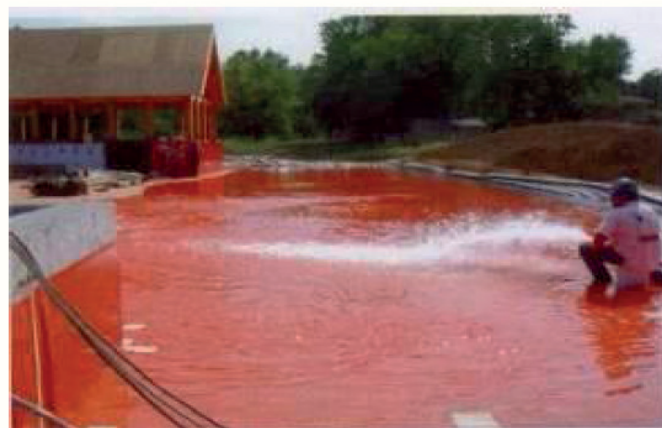
Ilustración 9. Instalación de membrana impermeable a base de PVC, en prueba de estanqueidad. (Grundfos 2011)
