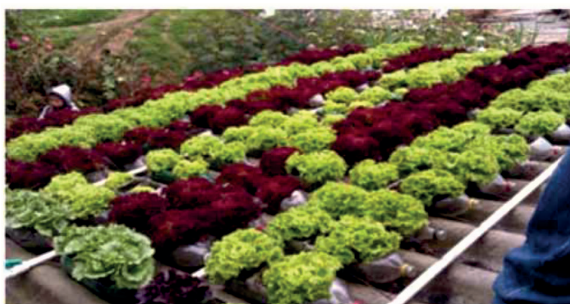
Ilustración 15. Cubierta verde construido con botellas plásticas interconectadas entre sí, con recubrimiento de dos tipos de vegetación. Forero-Cortes (2012),
