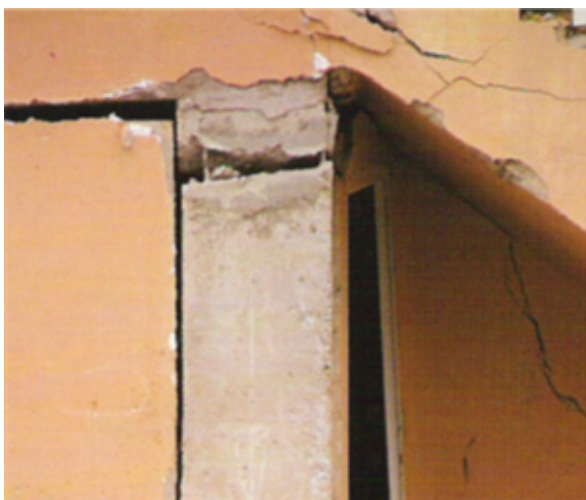
Figura 18. Rotura por tracción del pilar (Porto, 2005)
