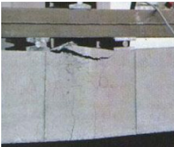
Figura 26. Aplastamiento por compresión de una viga. (Porto, 2005)
