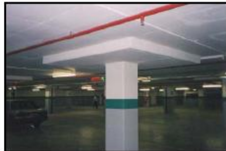
Fig. 6.3.1.d. Fotografía de losa con ábacos. [B1]
