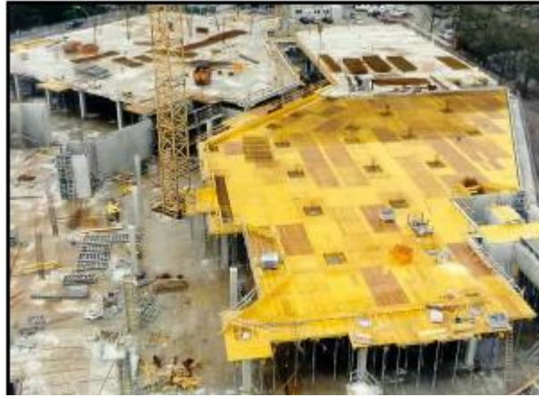
Fig. 7.5.2.a. Uso de mesas como encofrado. [B4]
