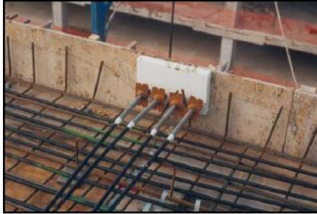
Fig. 8.3.6. Protección de anclajes antes del hormigonado. [B5]
