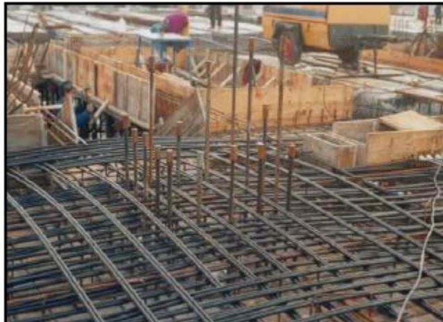
Fig. 7.4.1.f. Fotografía detalle de armado de un capitel. [B5]
