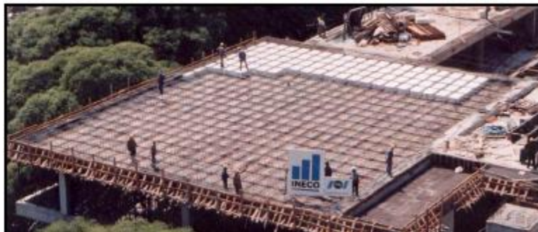
Fig. 6.3.1.g. Fotografía de losa aligerada en construcción. [B1]
