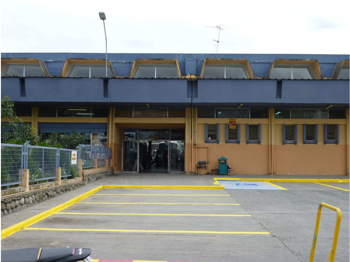
Figura 1-4. Cubierta del terminal terrestre de Cuenca.
