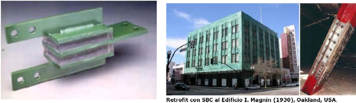
Retrofit con SBC al Edificio I. Magnin (1930), Oakland, USA.
